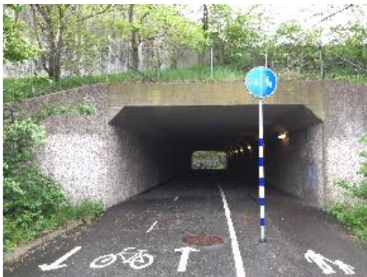
Gång- och cykeltunnel under E6 mot Skår
