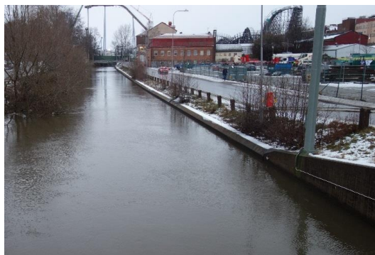
Foto på Mölndalsån, södra delen av området, vy från söder med stödmur öster om ån. (ÅF, 2018)
