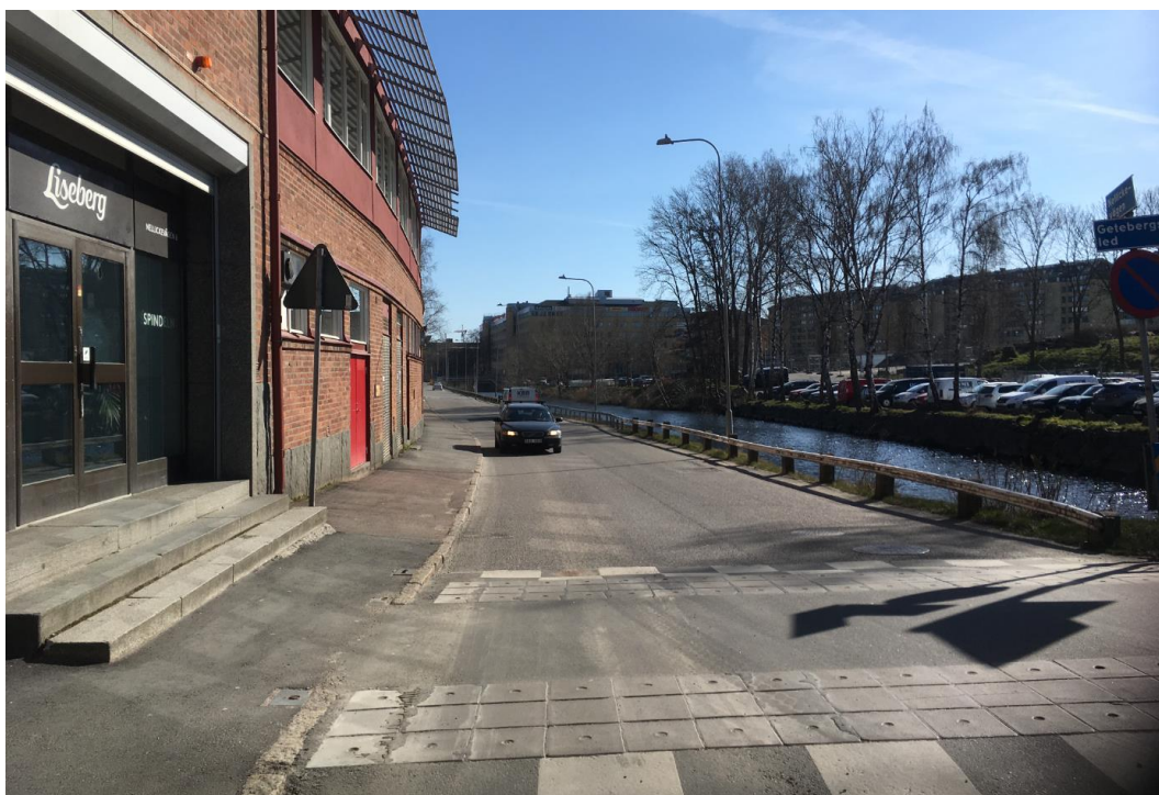
Figur 7 Smal gångbana med utskjutande trappa samt ej tillgänglighetsanpassad gångpassage.
