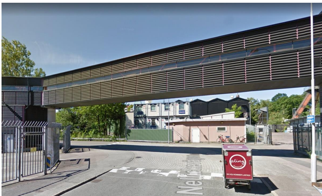
Figur 10 Gångpassage över Nellickevägen begränsar körbar höjd till 3,5 meter.
