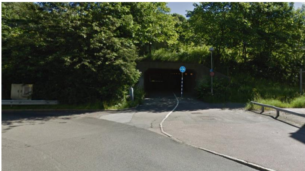
Figur 6 Gång- och cykeltunnel under E6an.
