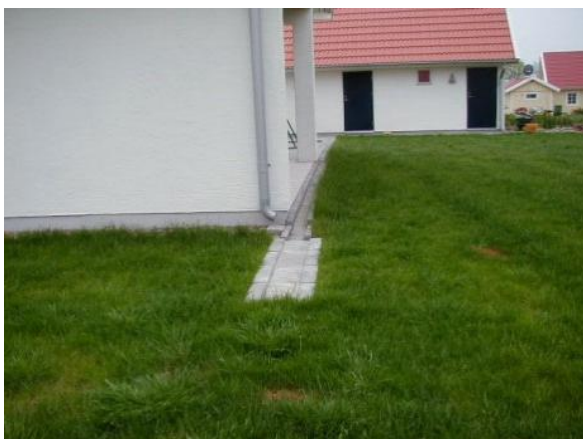
Bild 12 Stuprörsutkastare med rännalsplattor
