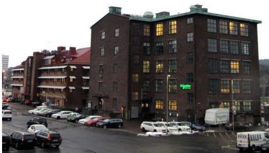
De två kontorsbyggnaderna i områdets östra del kan finnas kvar.
