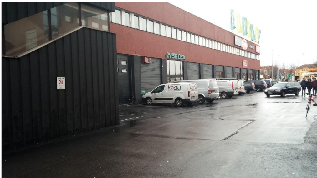
Figur 8. Vy mot norr över Krokslätt 154:6.
