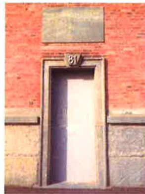
Den igensatta entrén med stenomfattning och ovanliggande stenplatta.
