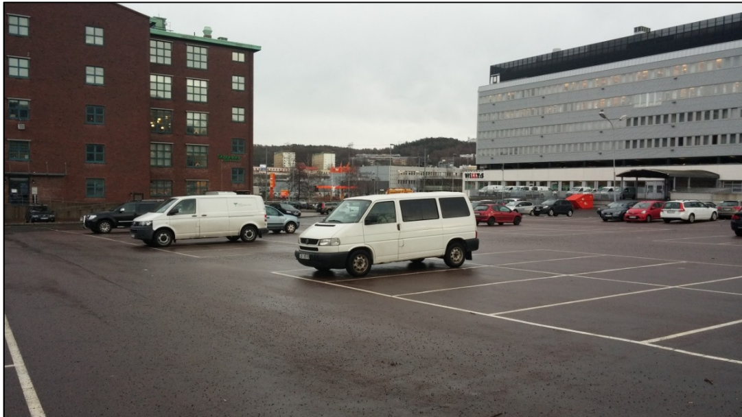
Foto 2. Planområdets södra del med öppna parkeringsytor och befintlig byggnad Mölndalsvägen 78 (till vänster). Foto taget åt sydöst.
