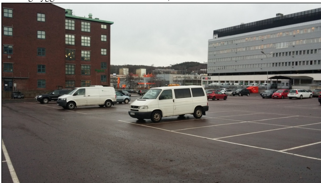
Foto 2. Planområdets södra del med öppna parkeringsytor och befintlig byggnad Mölnsdalsvägen 78 (till vänster). Foto taget åt sydöst.
