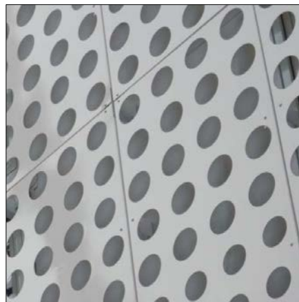
Figur 15. Perforerad plåtfasad med bakomliggande absorberande material.
