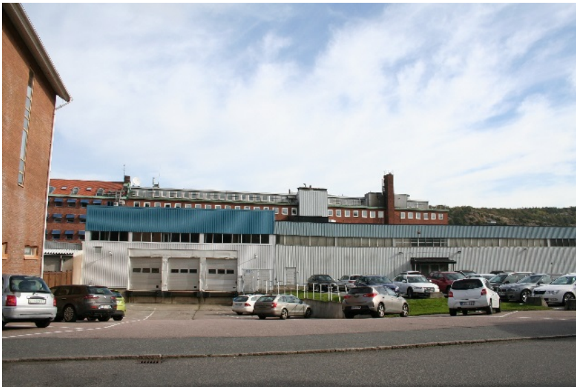
Lagertillbyggnader mot öster.
