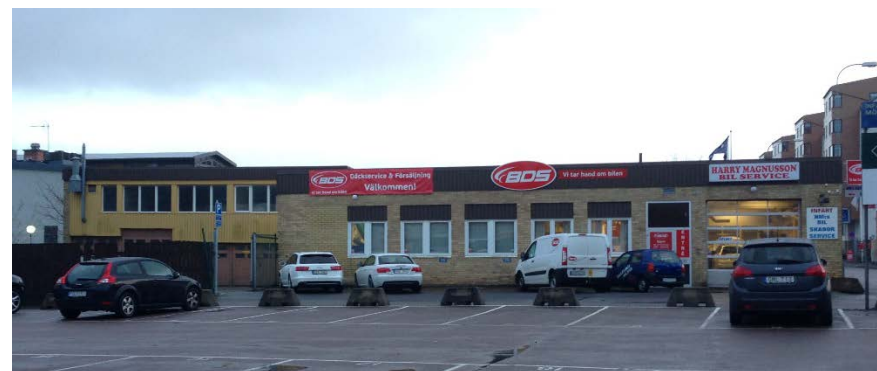
Fotografi mot söder. Till vänster i bild syns tillbyggnaden.
