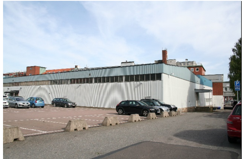
Lagertillbyggnad mot nordost.
