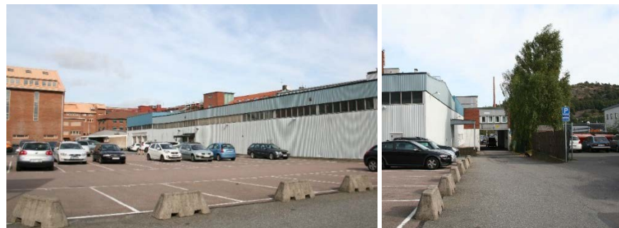
Fotografier från Ebbe Lieberathsgatan mot öster och de senare tillkomna byggnadsdelarna för grossistverksamhetens lager.
