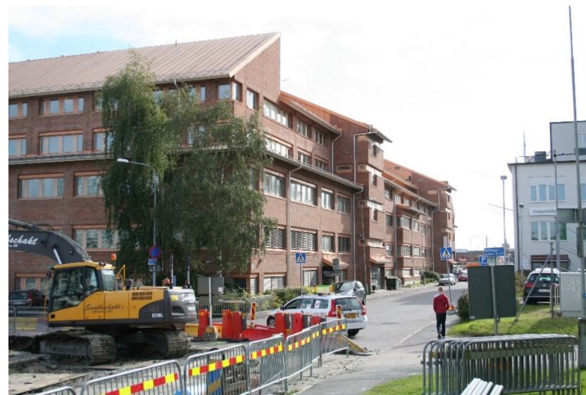
Vy från norr, längs Ebbe Lieberathsgatan och korsningen Varbergsgatan
