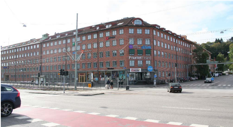
Vy mot sydväst, Mölndalsvägen 91
