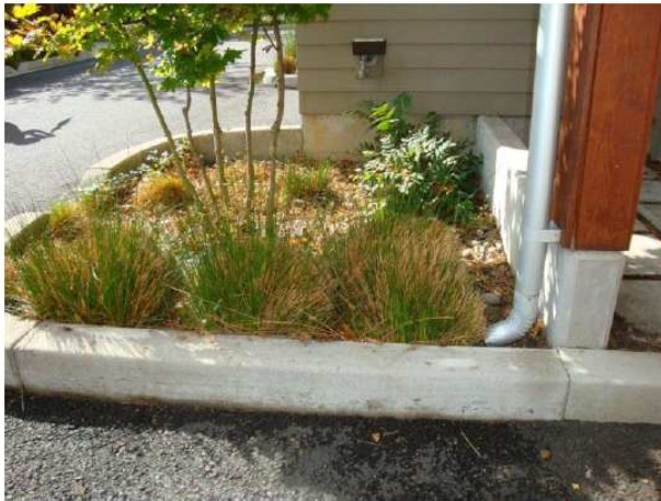
Figur 4 stuprör avleds till raingarden
