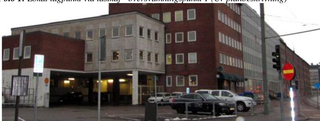
Foto 2: Lokal lågpunkt vid lastkaj - översvämningspunkt 1 (Ur planbeskrivning)
