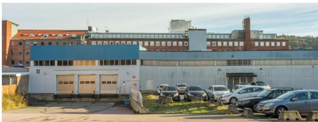
Foto 1: Lokal lågpunkt vid lastkaj - översvämningspunkt 1 (Ur planbeskrivning)
