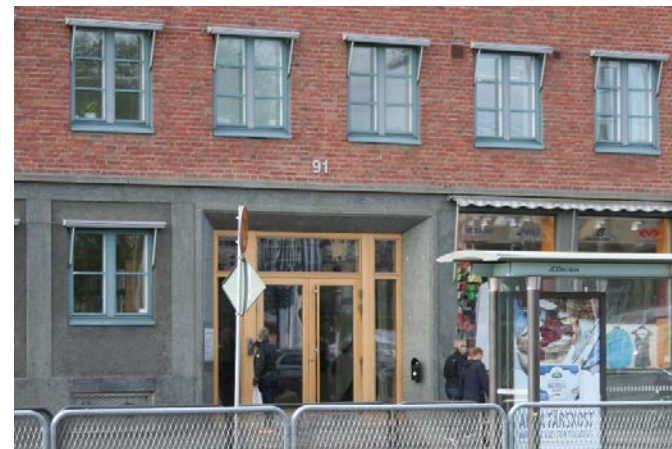
Detalj, entré mot Mölndalsvägen, första och andra våning.
