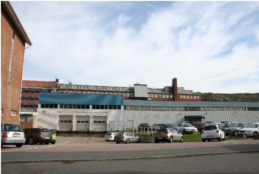
Lagertillbyggnader mot öster.
