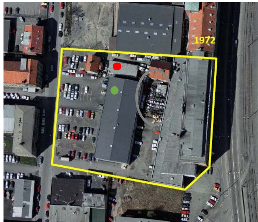
Flygfoto från år 1972. Planområdet ungefärligt markerat med gult. Bild från Översiktlig miljöteknisk markundersökning av Krokslätt 34:4, Göteborg , s. 6. Structor Miljö Göteborg AB 2014-12-19, något bearbetad.
