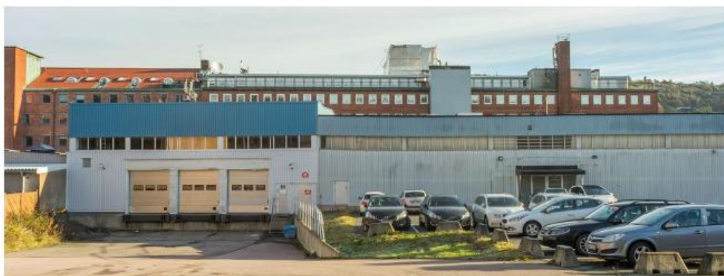
Foto 1: Lokal lågpunkt vid lastkaj - översvämningspunkt 1 (Ur planbeskrivning)
