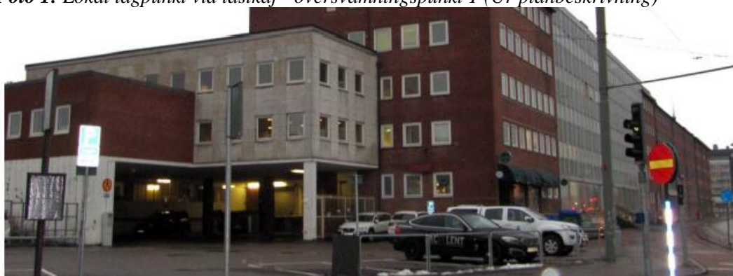
Foto 2: Lokal lågpunkt vid lastkaj - översvämningspunkt 1 (Ur planbeskrivning)
