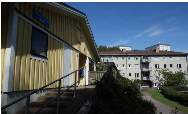
Tillbyggd del från 1970-talet berättar likaledes om funktionen genom småskalighet men ger ett tyngre uttryck genom brantare sadeltak och brädpanel med relativt tjocka hörnlistor.
