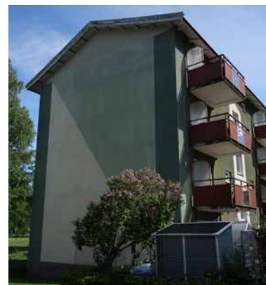
Smalhus på 10 meters bredd, orienterade för maximalt ljusinsläpp med balkonger mot väster eller söder. Bärande gavelväggar har dekorativt genomfärgade putsfasader.
