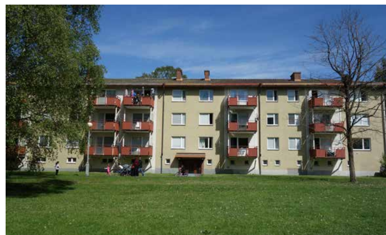
3-våningshus med genomfärgade putsfasader. Tegeltäckt tak och tegelskorstenar bidrar till en tidstypisk 50-talskaraktär.
