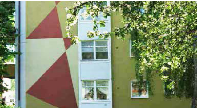
Lekfulla färgfält i de putsade befintliga fasaderna.
