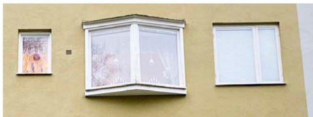
Tidstypisk 50-talsfönstersättning. Olika indelningar av spröjs och fönsterstorlekar samt något utbyggda burspråksfönster. Takfoten är relativt nätt och kort. Tidstypiska putsfasader i gröna kulörer blandat med ljusare puts i fält.
