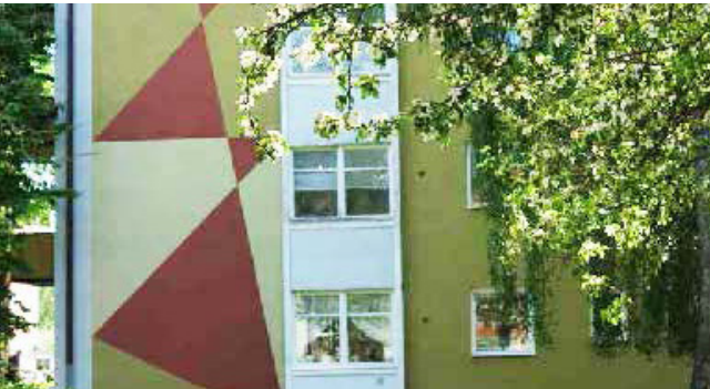
Lekfulla färgfält i de putsade befintliga fasaderna.
