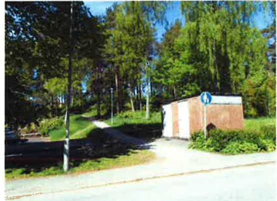
Befintlig gångväg från Adventsvägen med befintlig transformatorstation.
