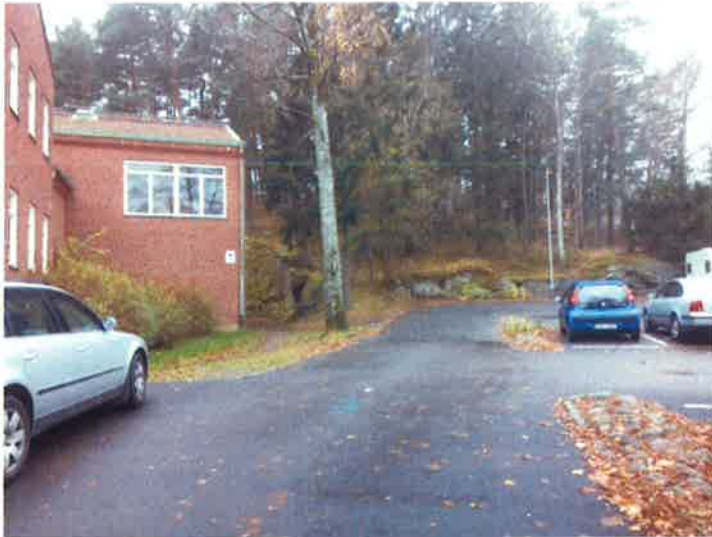
Befintlig infart till parkeringen vid förskolan. Lövåsskolan till vänster med gångstigen runt huset.
