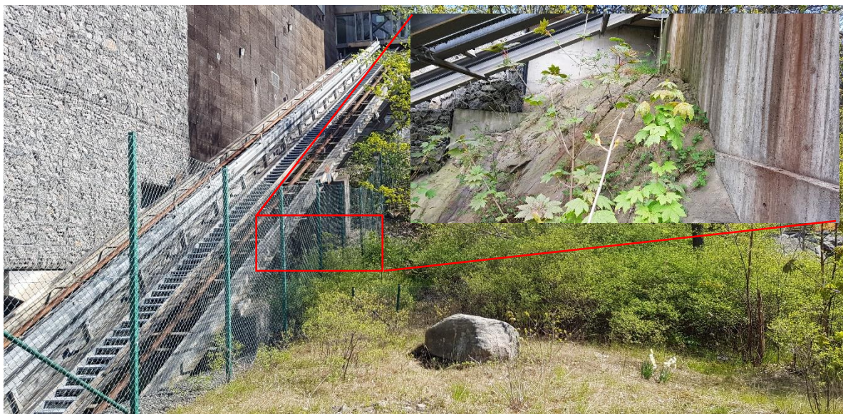
Figur 5. Översikt över området vid planerad grundläggning av pelare. Notera läget för betongfundament för befintlig hiss.
