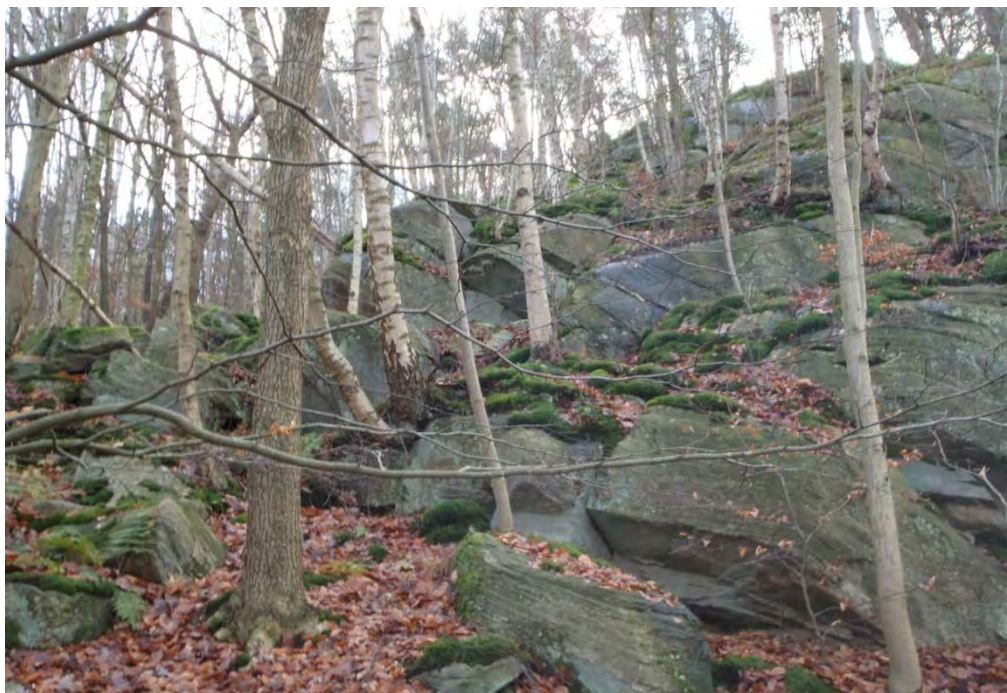
Foto 16. Den östra sidan av bergsryggen är mer blockuppsprucken. Bilden är tagen mot söder mellan de båda bergrumspåslagen, i den övre delen av slänten.
