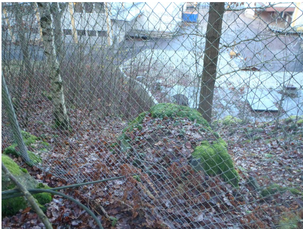
Foto 7. Vajerförankrat block ovanför påslaget till det östra bergrummet.
