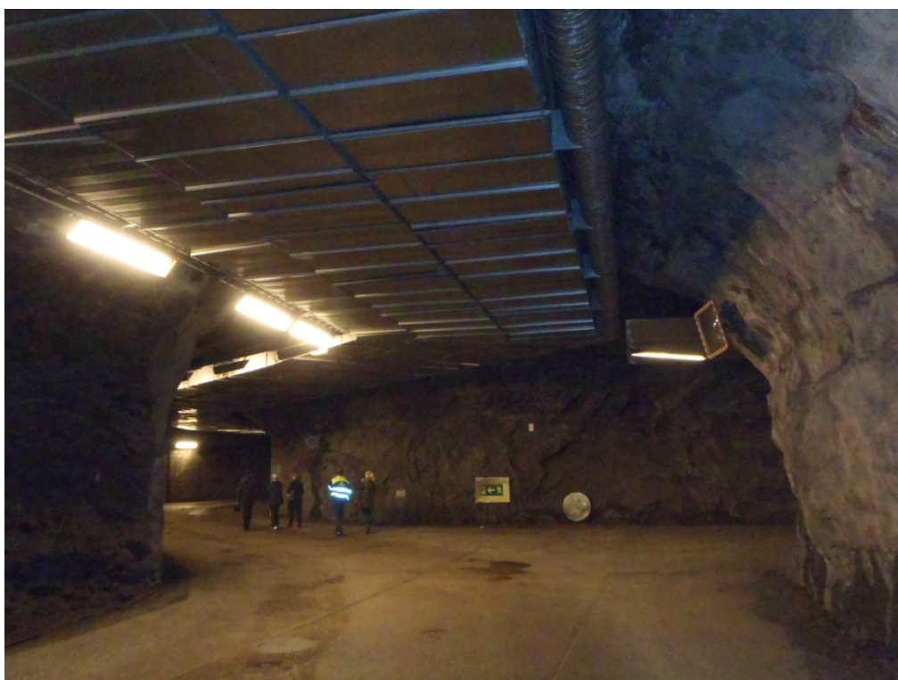
Foto 6. Ingången till det västra bergrummet, sett inifrån bergrummet. Bergväggarna är delvis täckta av sprutbetong, längre in enbart blottat berg med enstaka bult och bergnät. Observera foliationslutning snett ner mot vänster i bergväggen längst bort i bild.
