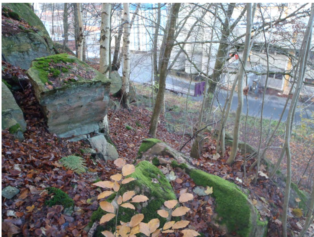
Foto 10. Instabila block i slänten ovanför kulverten och dess ventilationsstack. Område A.
