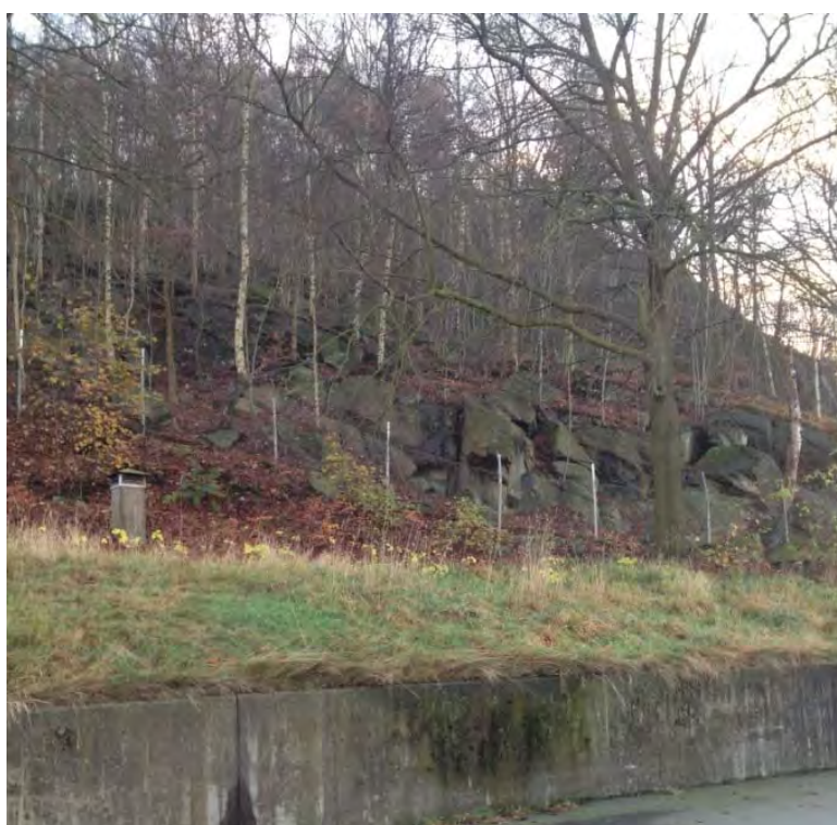
Figur 2 Mindre stödelement som visar att avschaktning utförts.
