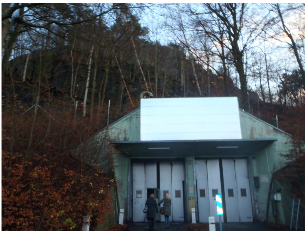
Foto 4. Ingång till det västra bergrummet.
