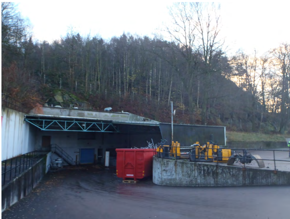
Foto 1. Ingång till det östra bergrummet.
