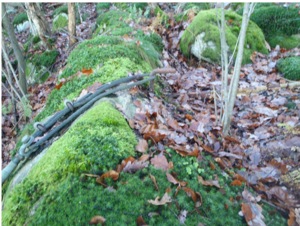
Foto 8. Vajern förankras i ett bakomliggande block.
