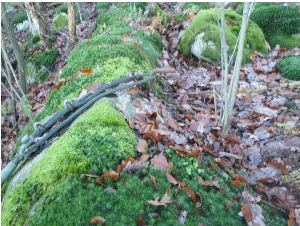
Foto 8. Vajern förankras i ett bakomliggande block.
