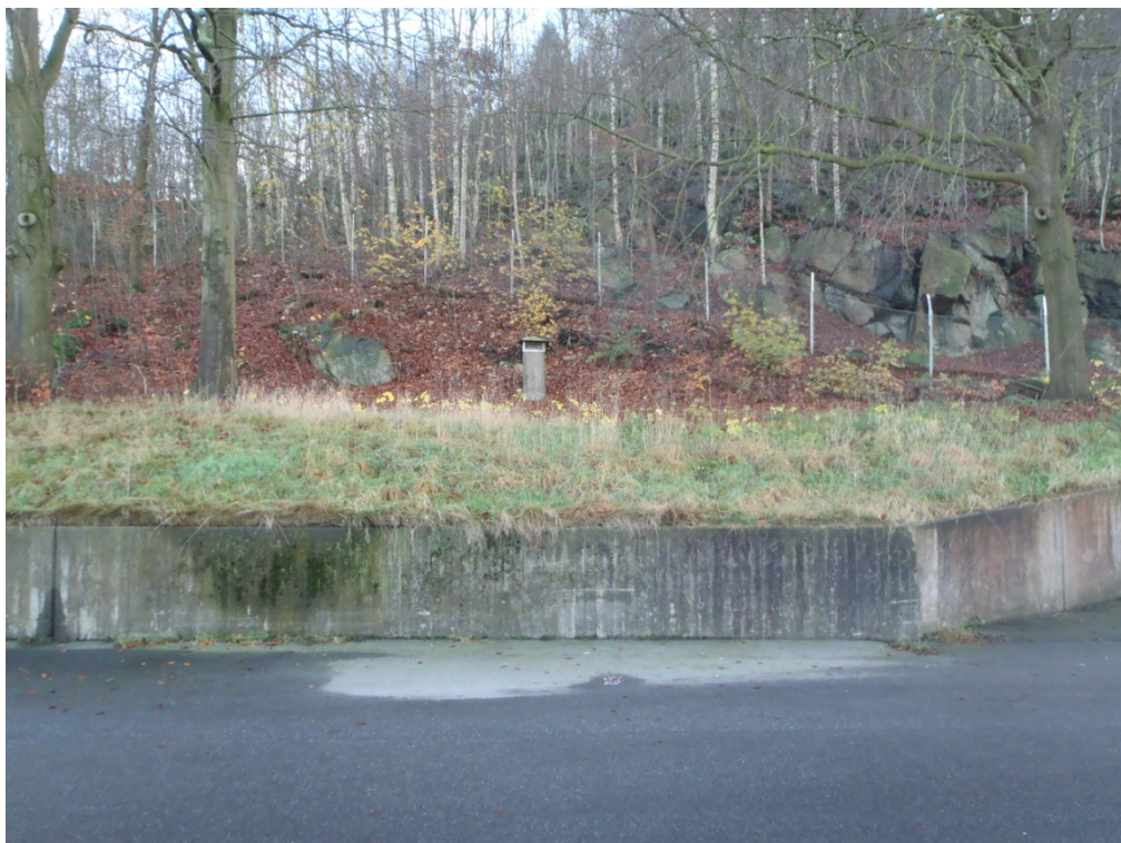
Foto 3. Läge för kulvert mellan det östra bergrummet och industribebyggelsen (bakom kameran). Observera ventilationsstacken och torr asfalt där kulverten går.
