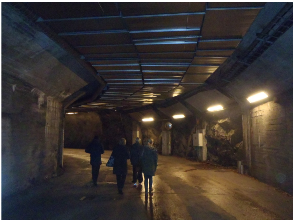
Foto 5. Ingången till det västra bergrummet med betongkonstruktioner, sett från mynningen.
