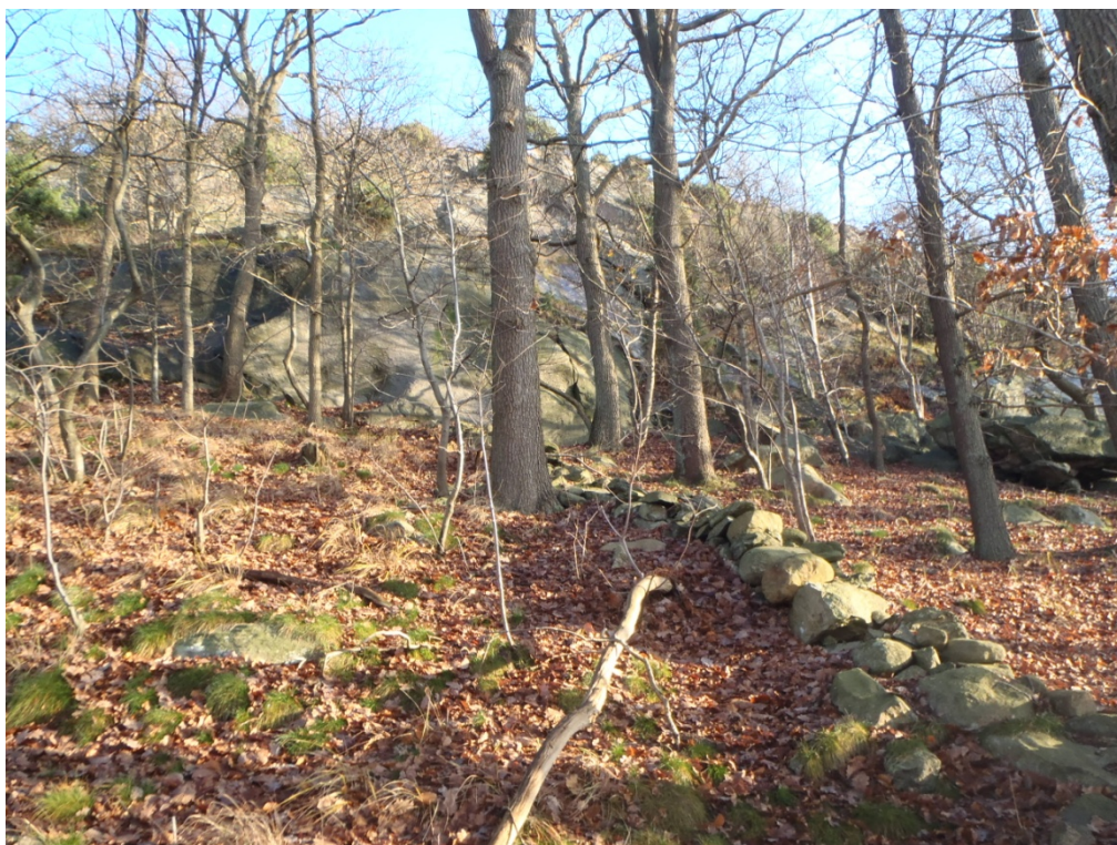
Foto 14. Tomtgränsen med aktuellt undersökningsområde till vänster, där bergslänten bedöms vara stabil. Till höger om tomtgränsen förekommer utglidande bergskivor utan bottenstöd.
