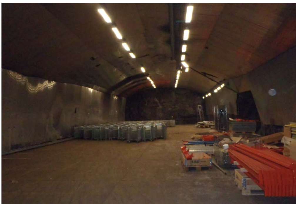
Foto 2. Den västra delen av det östra berggrummet med ingång till kulverten mitt på den högra väggen. Plåtinklädnad och blottat berg.
