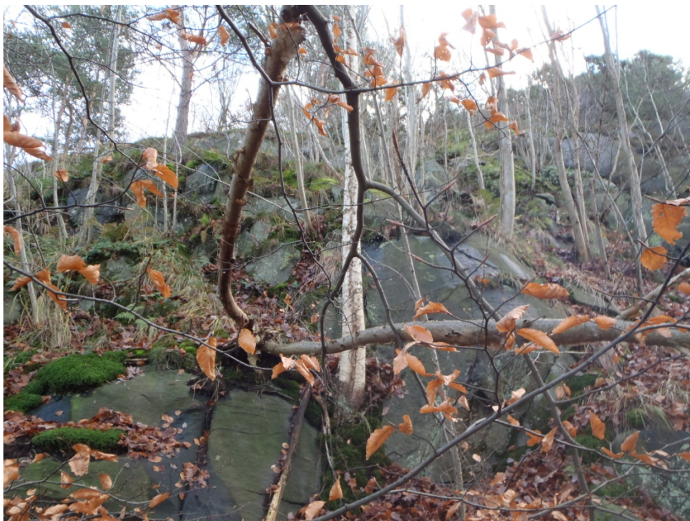
Foto 15. I den övre delen av slänten ovanför det västra bergrummets påslag är berggrunden blockuppsprucken men bedöms vara stabil. Bilden är tagen söderut från ett flackt parti som fångar upp eventuella utrullande block.
