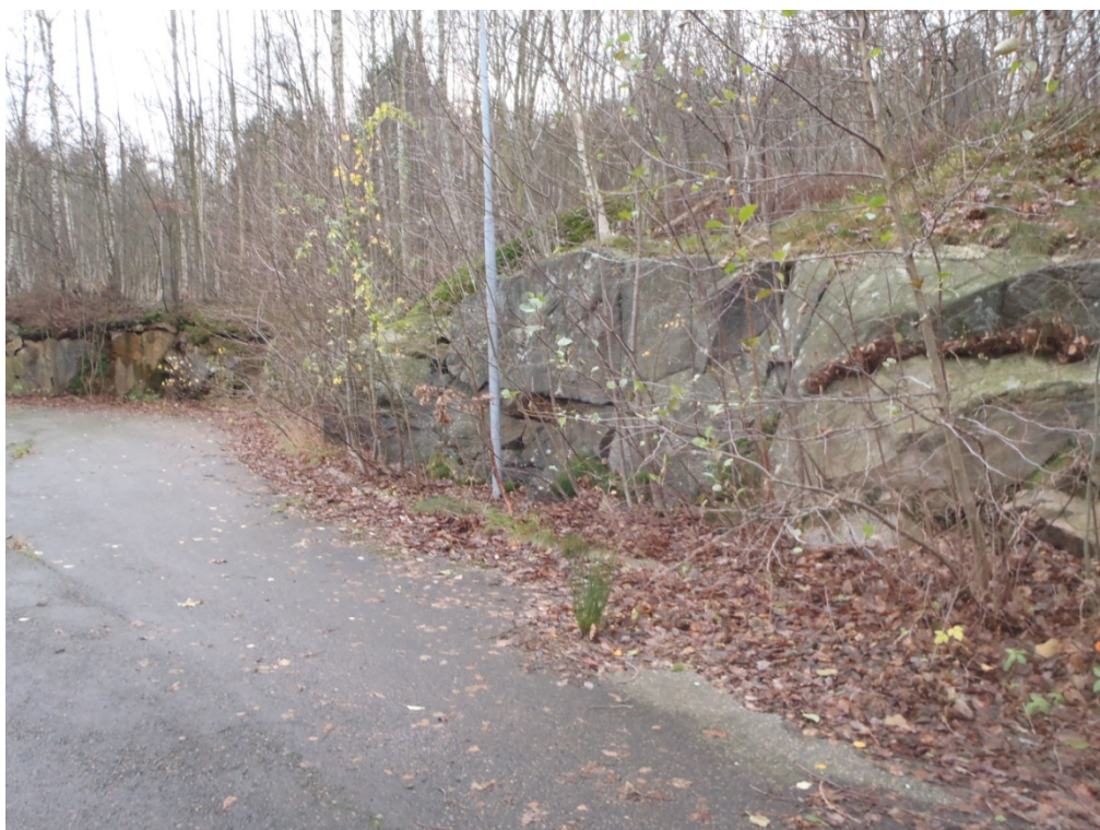
Foto 20. Bergskärning runt den övre parkeringsytan i industriområdets östra del. Vy mot söder.
