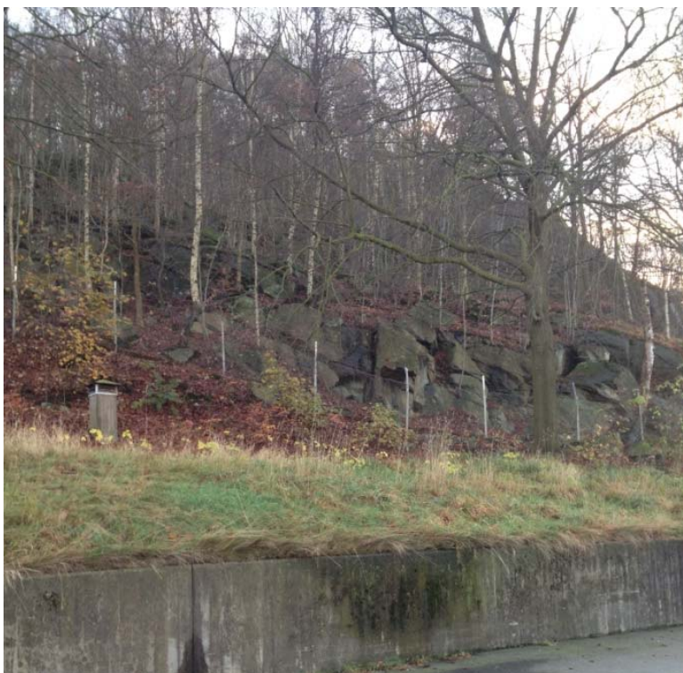
Figur 2 Mindre stödelement som visar att avschaktning utförts.
