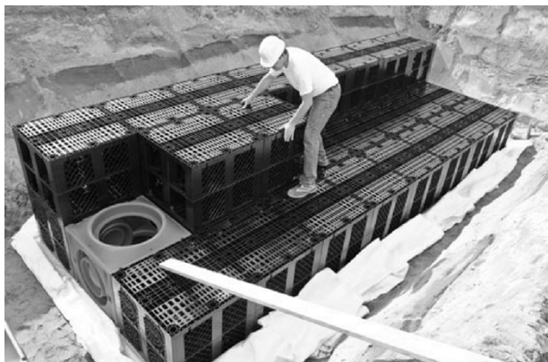
Figur 39: Dagvattenkassetter (www.rehau.com)
