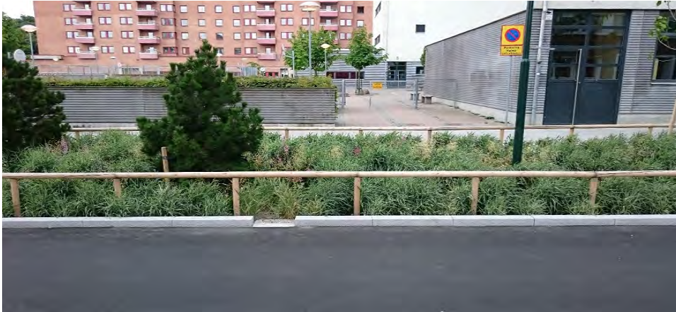
Figur 41: Nedsänkt växtbädd med inlopp genom nedsänkt kantsten.
