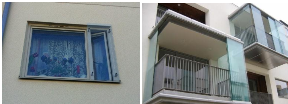
Figur 4: Exempel på glasparti framför fönster och delvis inglasning av balkong
