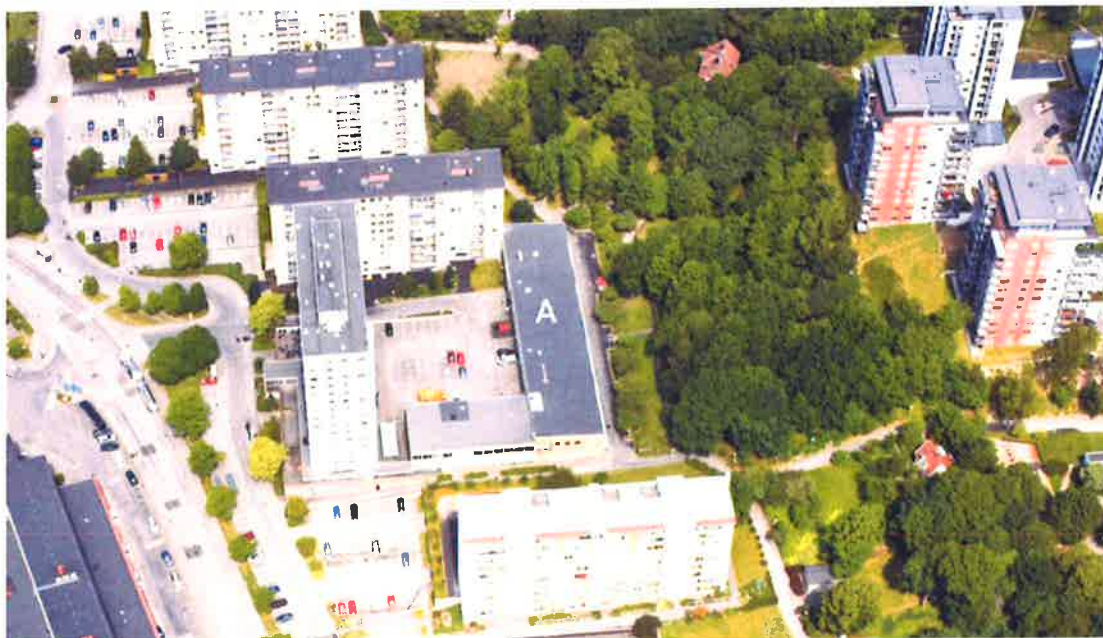
Planområdet sett ifrån söder; mitt i bilden syns befintlig byggnad inom planområdet [A], till höger därom Mjölktorget och Kallebäcksparken.
