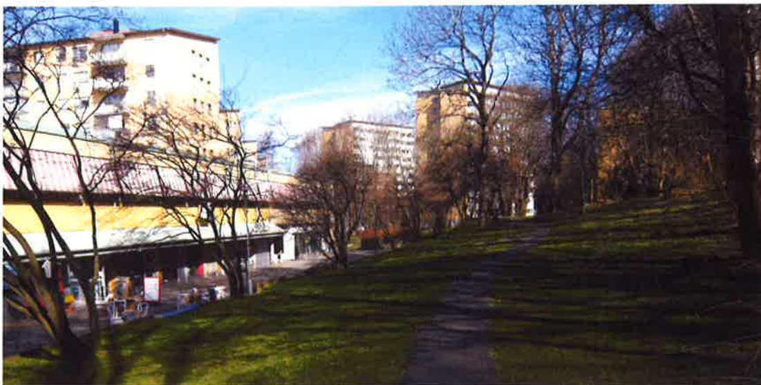
Kallebäcksparken sedd ifrån söder, tv. befintlig tvåvåningsbyggnad som föreslås rivas.
