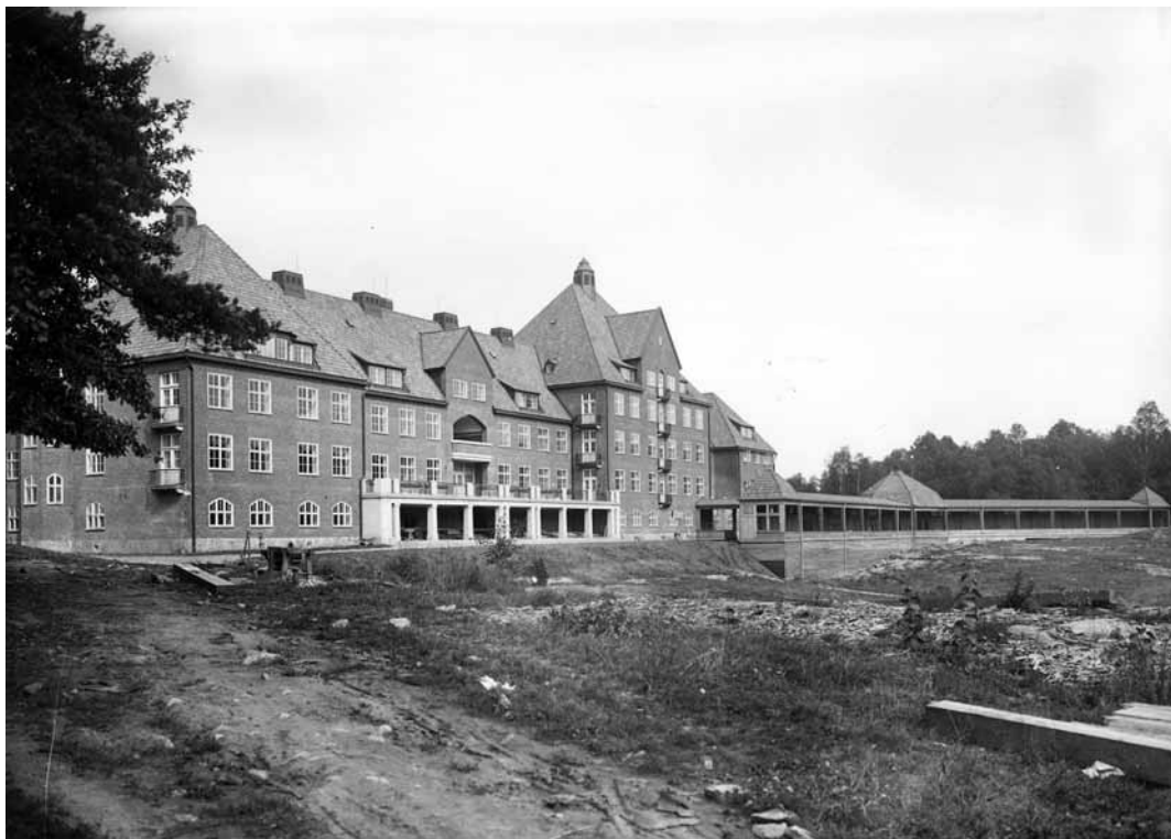
Renströmska sjukhuset, 1913 under byggnation
