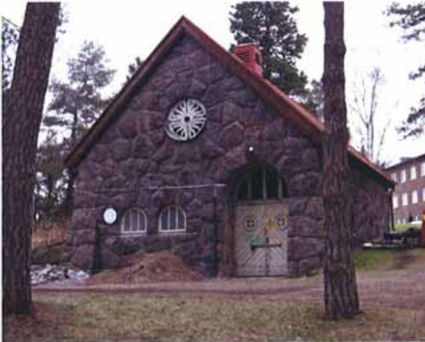
Figur 41. Sjukhusets före detta lik- och obduktionsbyggnad från ca 1910-talet med äldre tallar framför inom yta 6.
