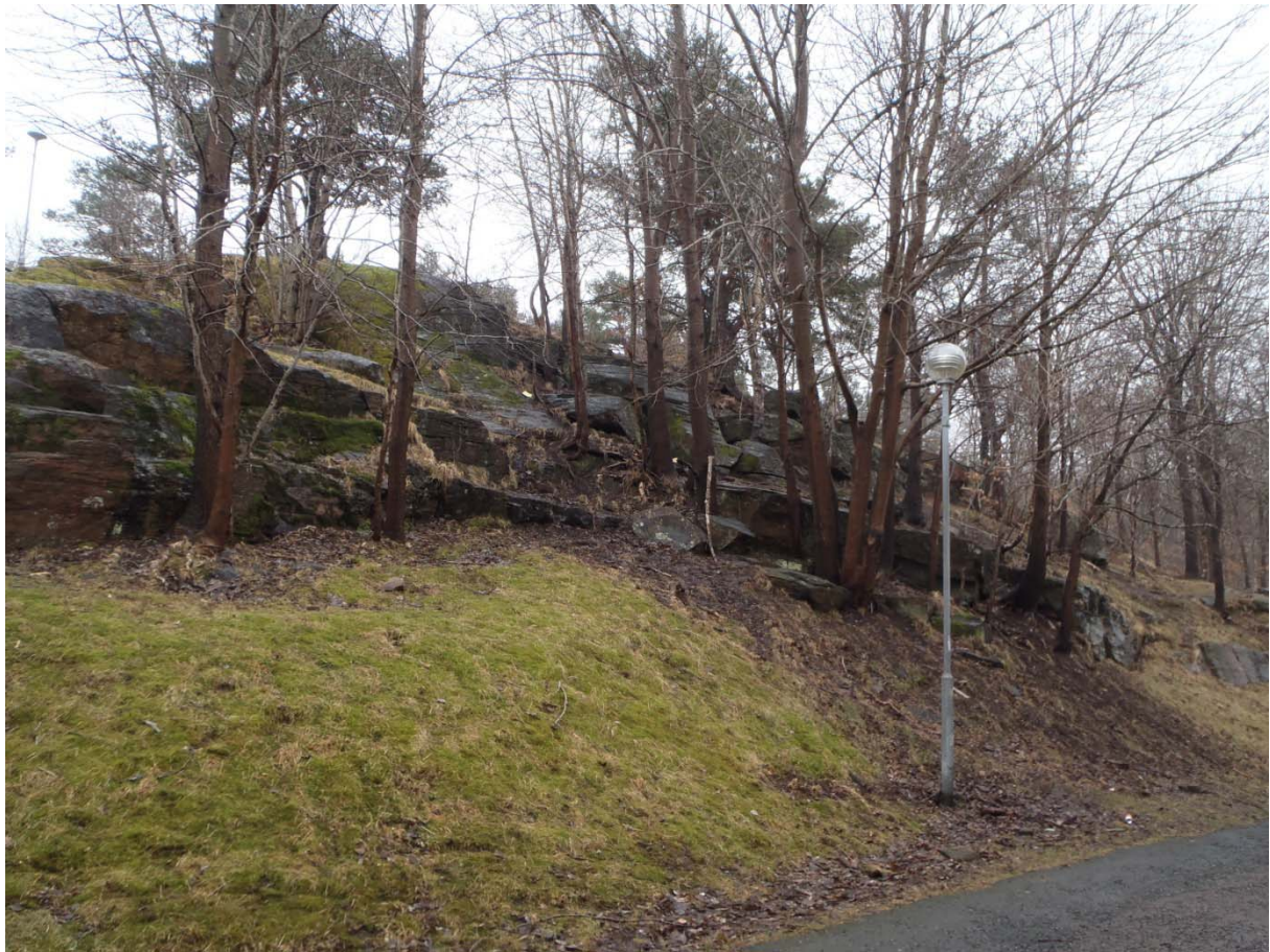
Foto 7. Slänten bakom Kålltorpsskolan. Den södra delen (bilden) bedöms vara stabil men enstaka potentiellt instabila block noteras i den norra delen (punkt 3 i Bilaga 2).
