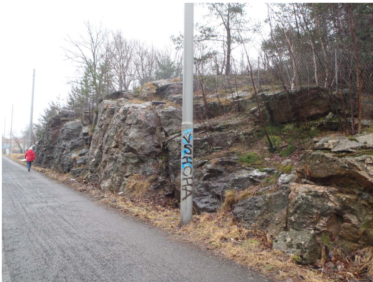
Foto 2. Skärningen mot Torpagatan (punkt 1 på planritningen i Bilaga 2). Enstaka instabila block noteras i skärningen.
