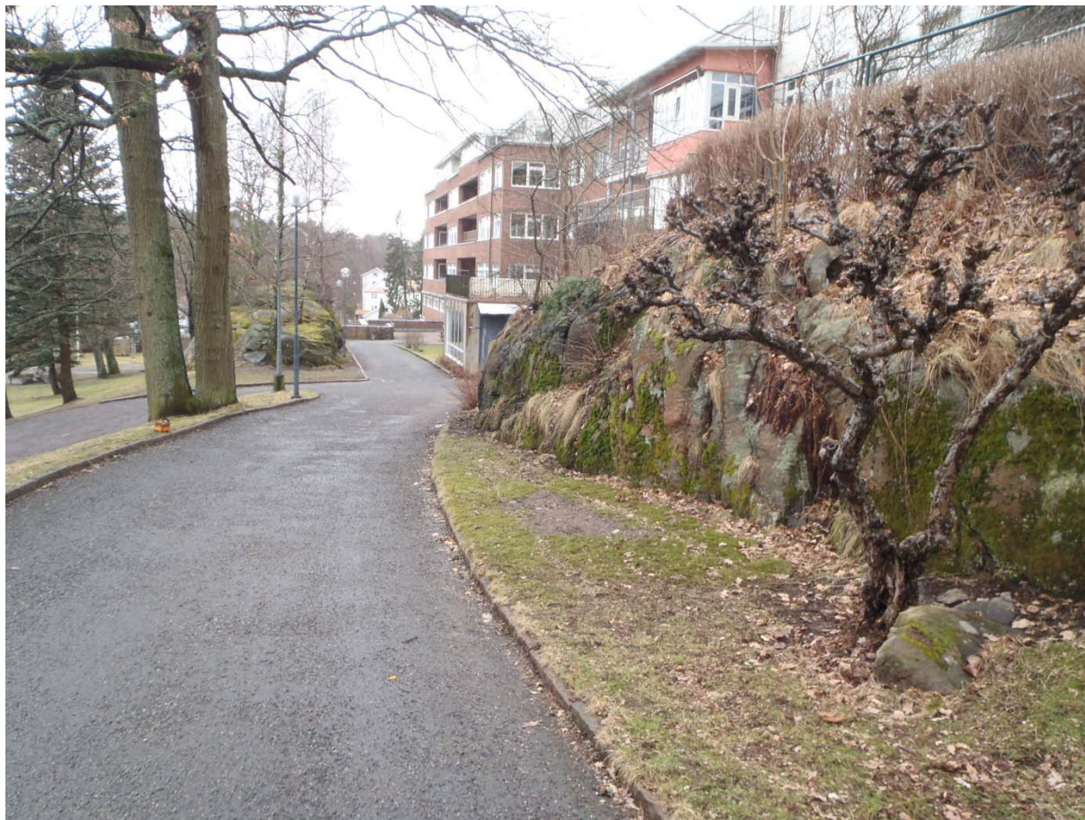
Foto 9. Slanter och skärningar på södra sidan av Renströmska sjukhuset bedöms vara stabila.
