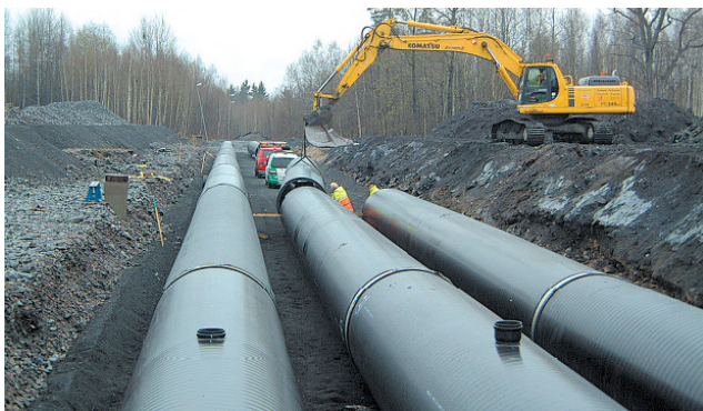
Bild 9. Dagvattenmagasin av Weholite dubbelväggiga lättviktsrör, polyeten. Källa: www.kwhpipe.se
