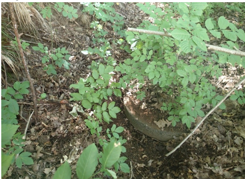
Foto 5. Diken i norr leder till en gammal övertäckt brunn
