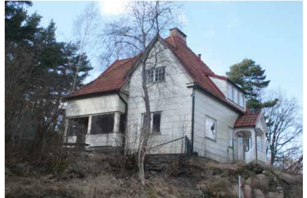
Fasad mot söder med utsvängt takfall och förstukvist
