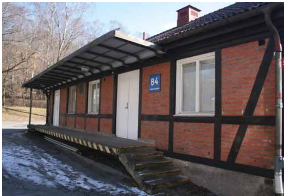
Fasad mot norr med lastbrygga
