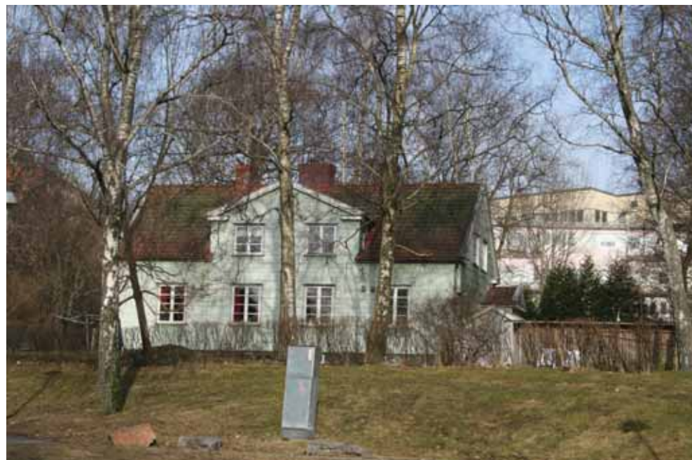
Den västra fasaden med mittparti
