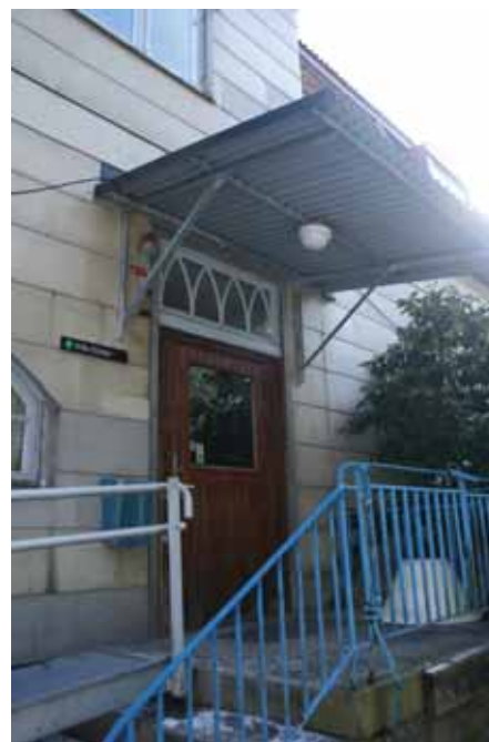
Stentrappa med smidesräcke samt ytterdörr med utsmyckat glasparti
