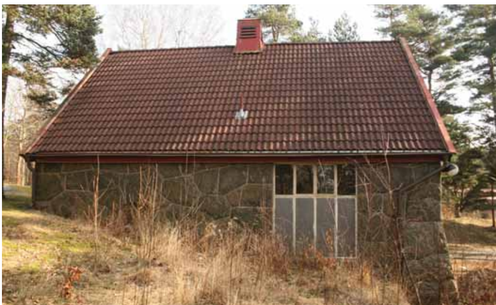
På byggnadens västra fasad finns ett större fönster
