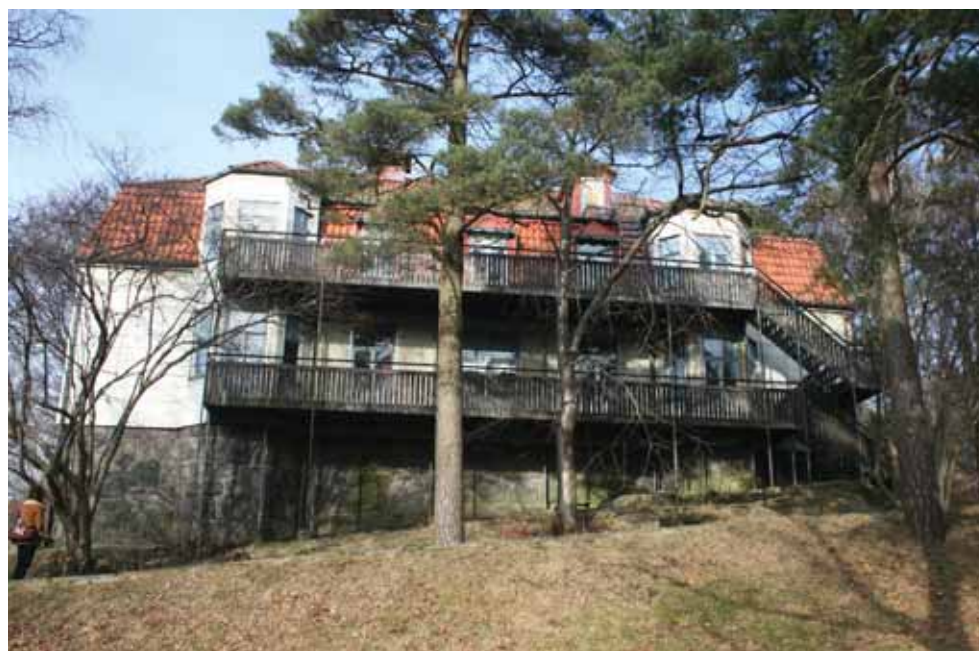
Södra fasaden med tillbyggd balkong från 1968
