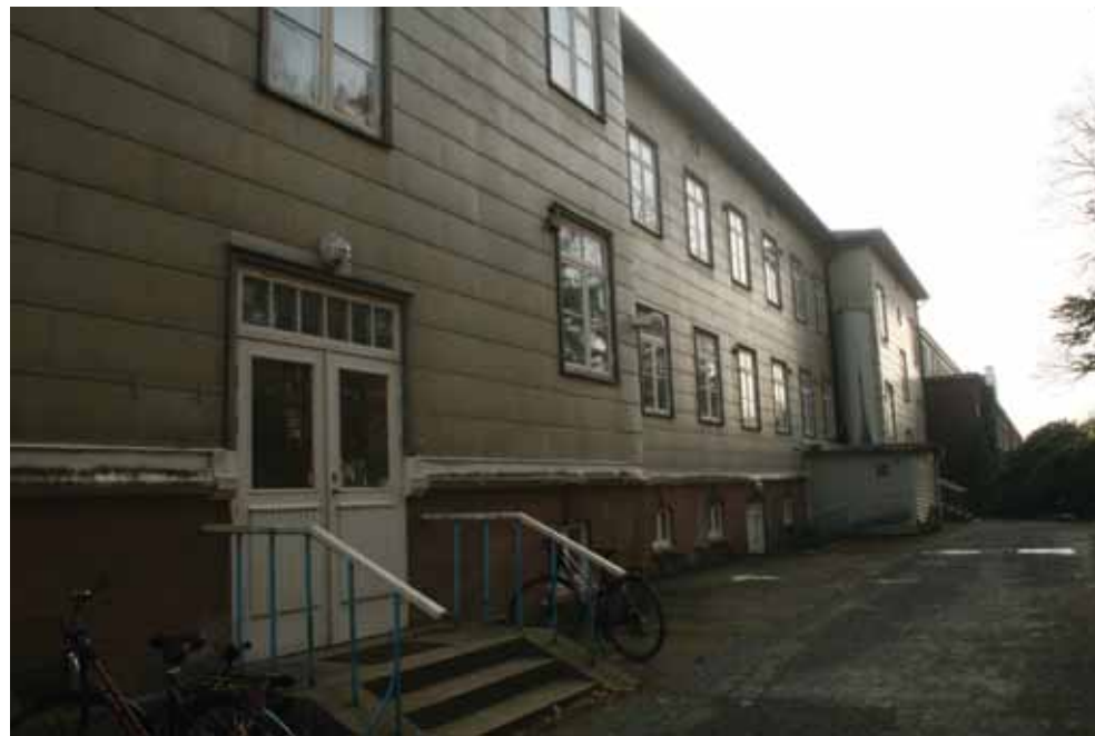
Fasad mot norr. En av de välbevarade dubbelportarna syns till vänster
