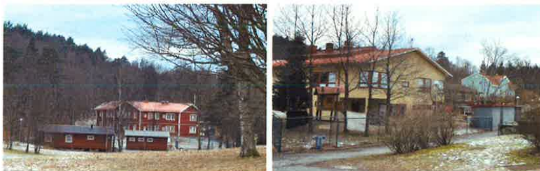
I sydvästra delen av området ligger Parkskolan och två mindre föreningslokaler.
