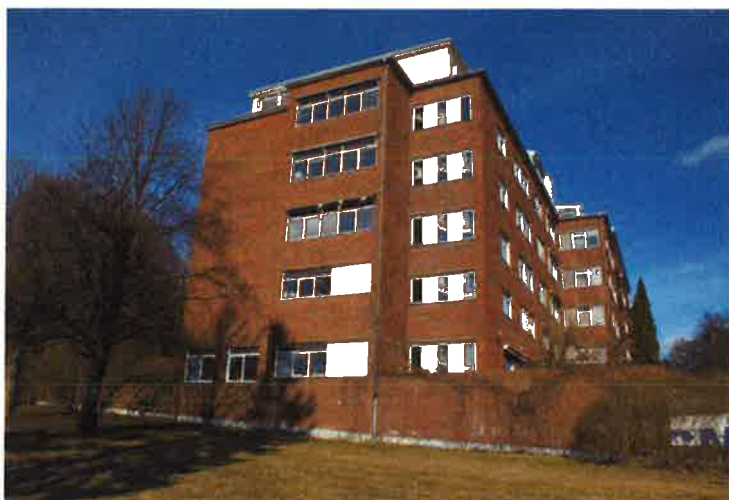
Kålltorps sjukhem nära Virginsgatan i planområdets sydvästra del. Byggnaden används inte längre som sjukhem.
