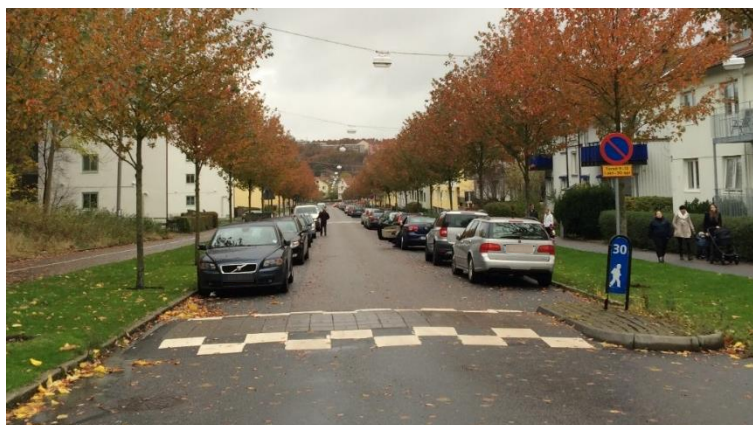
Figur 2 Virginsgatan, vy från öster. Dubbelsidig parkering innebär att endast trafik i en riktning i taget kan trafikera gatan. Gång- och cykelstråken på både sidor av gatan framgår också. Farthinder finns för att sänka hastigheten.
