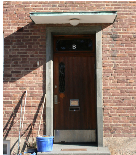
Port i teak med naturstensomfattning samt skärmtak med koppartäckning
