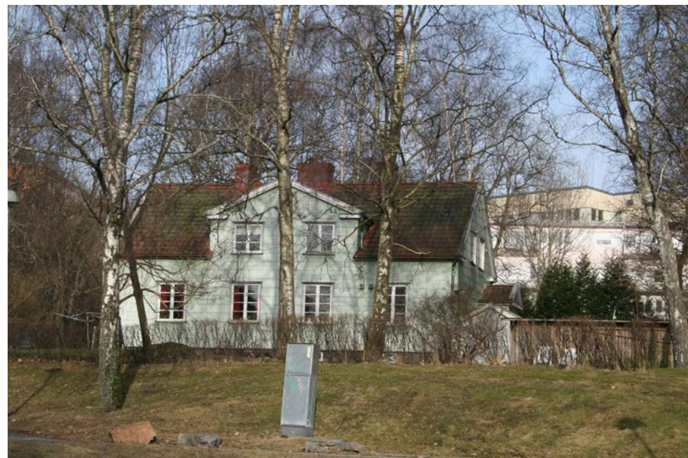
Den västra fasaden med mittparti
