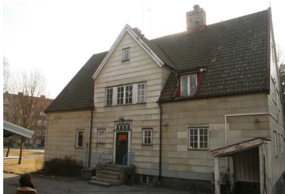
Nordvästra fasaden med stentrappa
