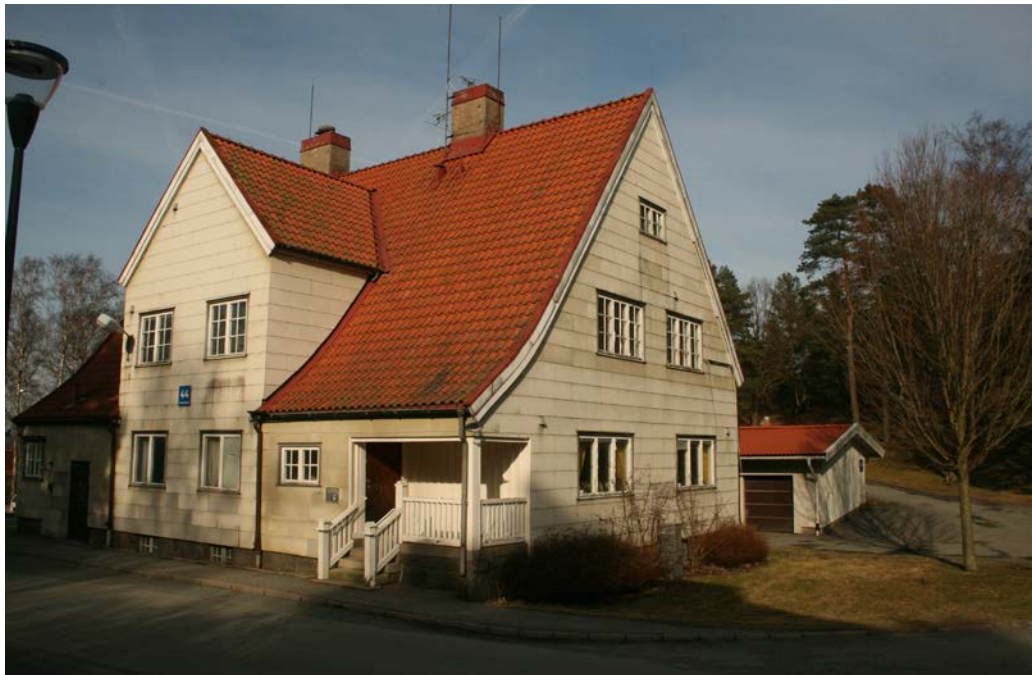
Sydöstra fasaden med förstukvist
