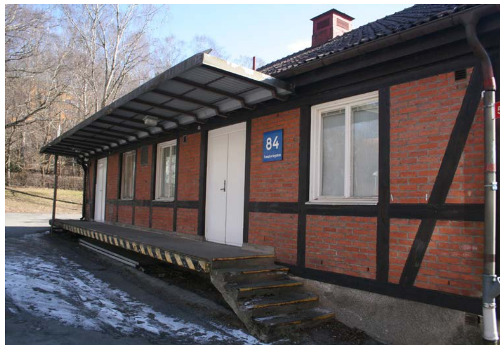
Fasad mot norr med lastbrygga
