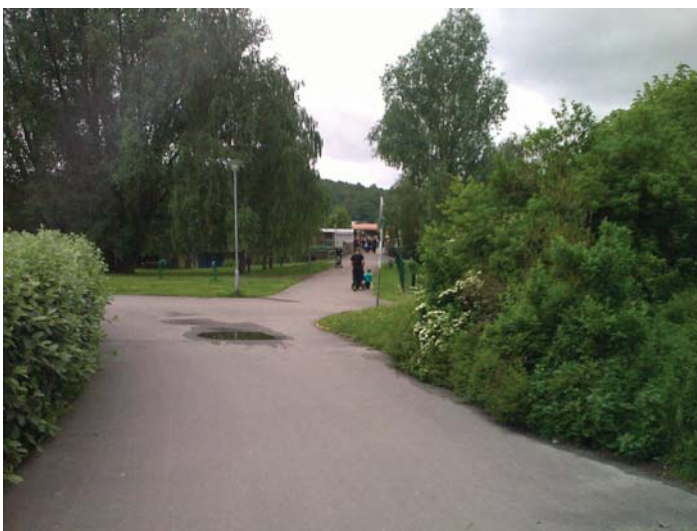
Bild 39 GC-nätet i höjd med busslussen på den östra sidan Lillekärr Södra/Norra.
