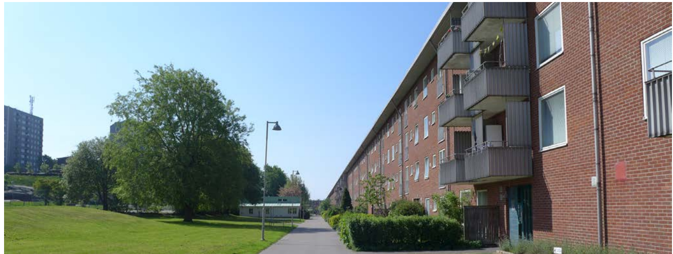
Kv Käppen består av ett 800 meter långt lamellhus i fyra våningar. Fasaderna är klädda med rött tegel och taket är flackt. Byggnaden sluter sig kring en stor och bilfri gård med mycket grönska. Här finns lekplatser och förskola.
