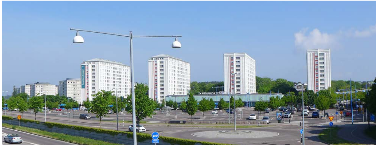
Utmed Näverlursgatan står fyra höga skivhus placerade i en strikt lamellhusplan i nordsydlig riktning. De utgör ett karakteristiskt inslag i miljön kring Frölunda Torg.
