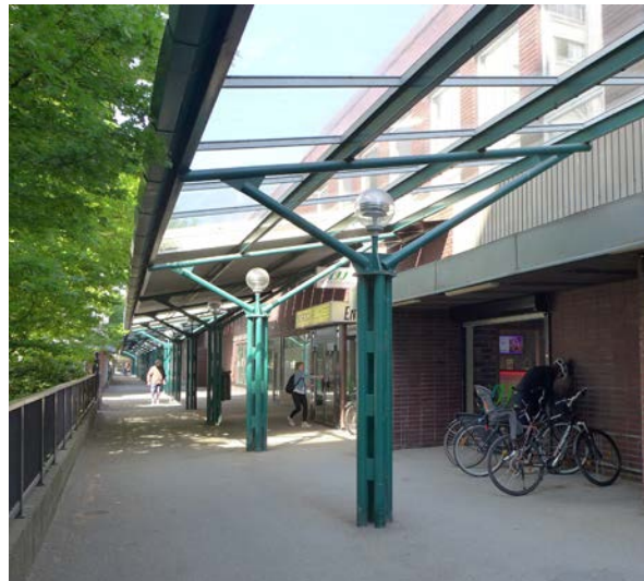
Gångstråk utmed centrumanläggningens butiksutlöpare vid Marconigatan med sitt skärmtak.
