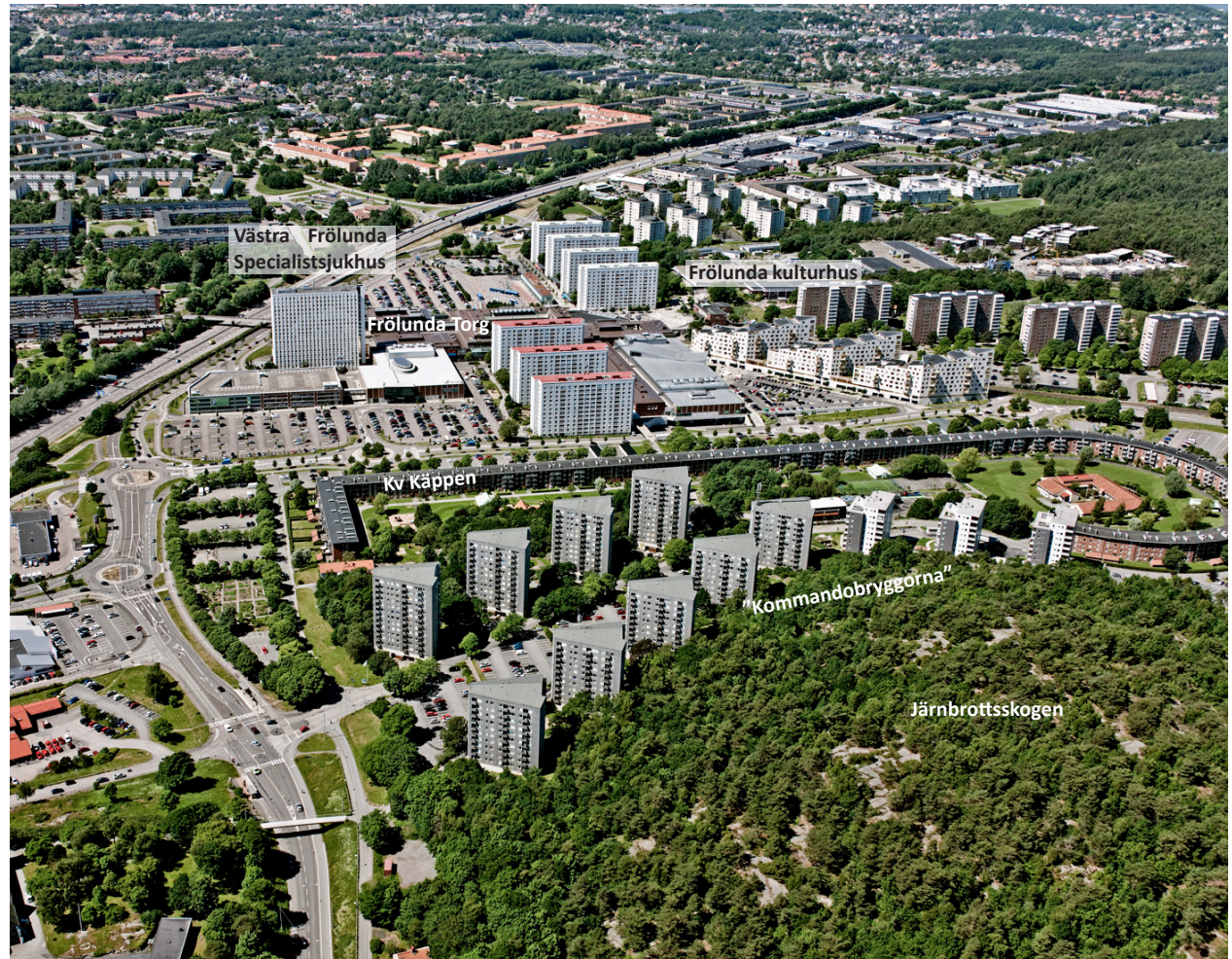
Planområdet består i huvudsak av parkeringsytor i anslutning till centrumanläggningen Frölunda Torg, kring vilket parkeringsytor och ett modernistiskt höghuslandskap breder ut sig. Källa: SBK
