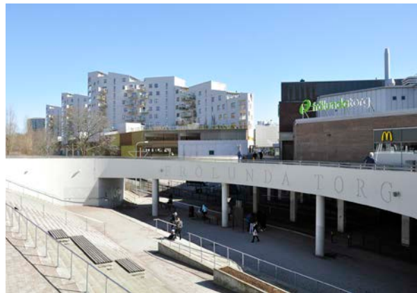
Separering av trafikslag är konsekvent genomfört i området. Centrumanläggningens undre plan gjordes lättillgänglig för spårvagnsresenärer medan de övre planet nåddes av bilisterna.
