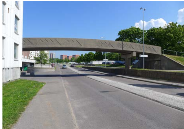
Miljön präglas av separering av trafikslag. Gångbron över Marconigatan fungerar även som ett konstnärligt inslag i miljön.
