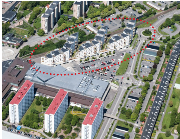
De moderna flerbostadshusen vid Lilla Marconigatan (markerade med rött) utgör ett gott exempel på hur modern bebyggelse kan inordnas på ett varsamt sätt i den befintliga miljön. Stora friytor mot omgivande bebyggelse har lämnats och vad gäller formspråket har t ex taket underordnats fasaderna.
