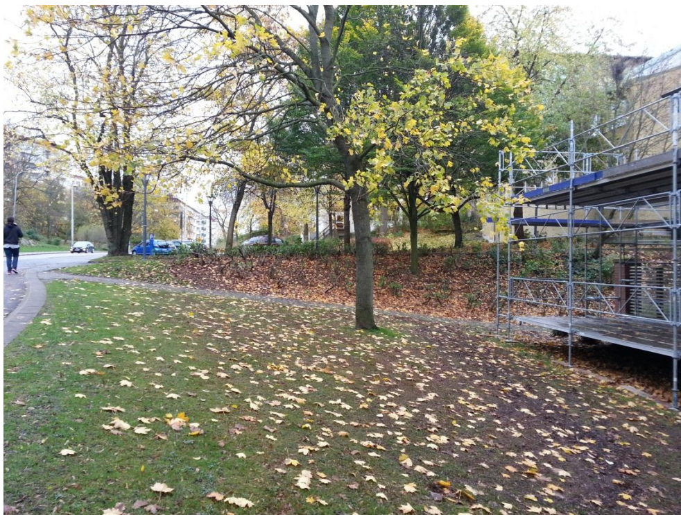
Bild 3. Jordslänt inom delområde 3, bild tagen i sydlig riktning.
