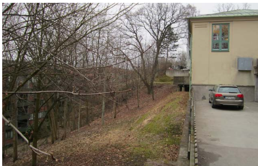
Slutningen nedanför bef. byggnader på Volrat Thamskatan. Sett söderut . (Foto J Henrikson)
