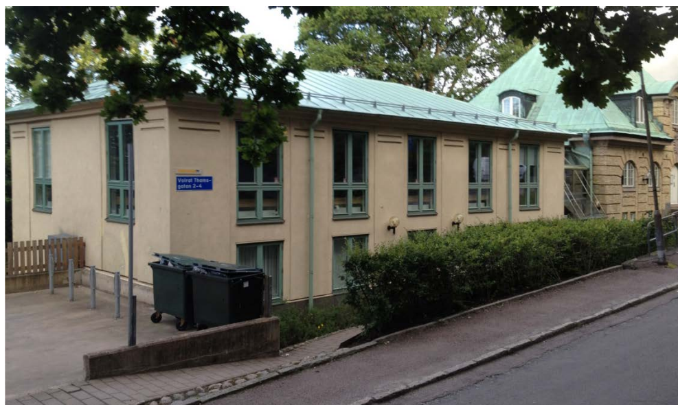
Den före detta pumpstationens tillbyggnad från 1985.
