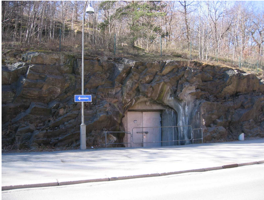
Ingång till arbetstunnel
