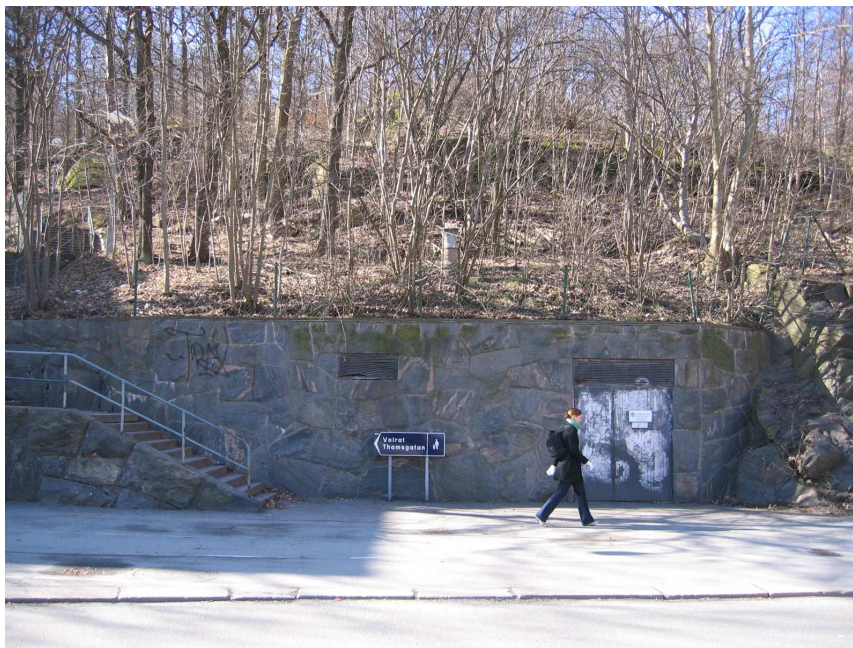
Pumpstation och trappa/gångväg
