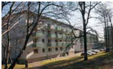
Eklandagatan, puts. Fasad mot berget. Källa: Melica (2012)
