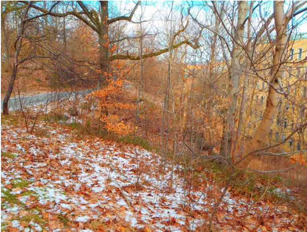
Foto 7. Den naturliga slänten ned mot Språkskrapan från Bernhard Karlgrens Gångväg (till vänster i bild) bedöms idag vara stabil. Bilden tagen mot norr.
