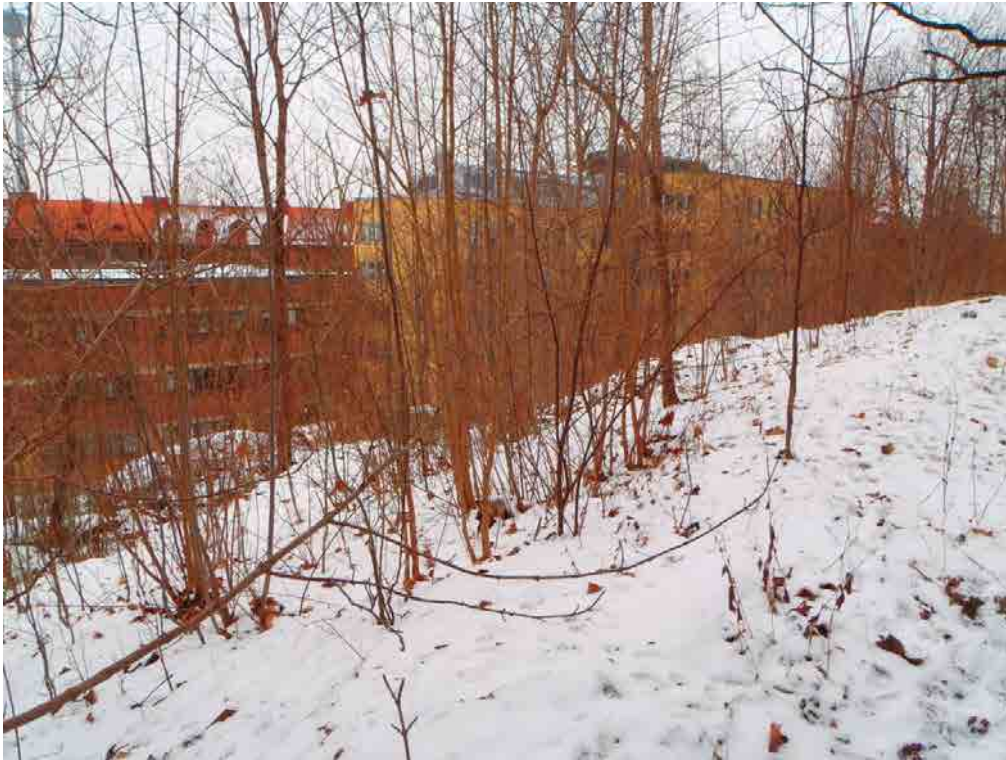
Foto 7. Södra delen av eventuell bergschakt, vid Bernhard Karlstens Gångväg. Bakre schaktvägg planeras löpa ungefär längs med grenen i bildens nedre vänstra sida. Slänten bedöms idag vara stabil. Bild tagen mot öst.
