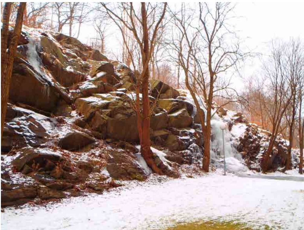
Foto 4. Norra delen av bergskärningen bakom Språkskrapan. Löst bergmaterial finns i skärningen, liksom potentiellt instabila större block. Bergrensning och bultning bör utföras. Bild tagen mot nordväst.
