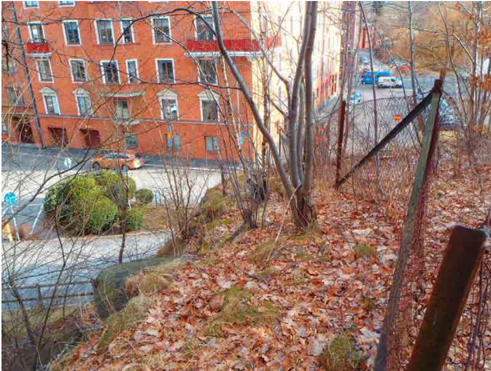
Foto 7. Bergskärningen mot Språkskrapan (utanför bildens vänstra sida). Eventuell bergschakt för ny byggnad vid Carlandersplatsen utförs i bildens högra sida. Den planerade norra schaktväggen löper längs staketet. Kvarvarande bergribba mot Språkskrapan blir mycket smal. Bilden tagen mot nordväst.
