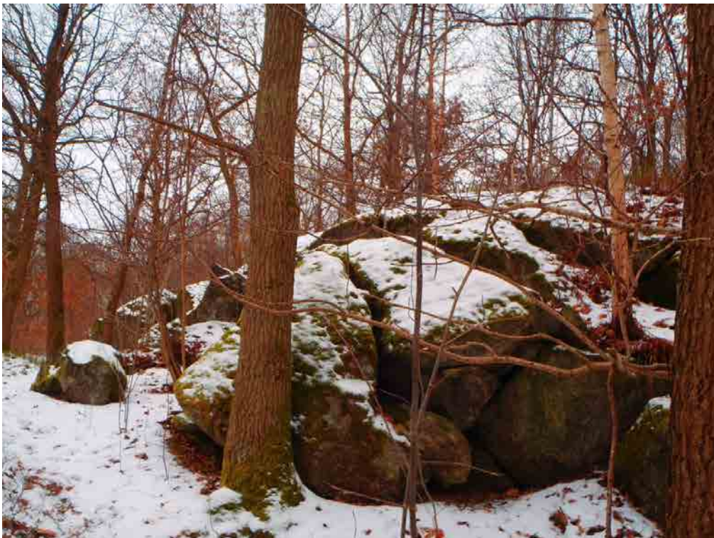
Foto 8. Den naturliga slänten väster om Bernhard Karlgrens Gångväg bedöms idag vara stabil men ett blockuppsprucket parti finns ungefär mitt emot Språkskrapan. En eventuell bergschakt i direkt anslutning detta parti (till vänster i bild i så fall) kan destabilisera blocken som då bör tas bort. Bild tagen mot sydöst.
