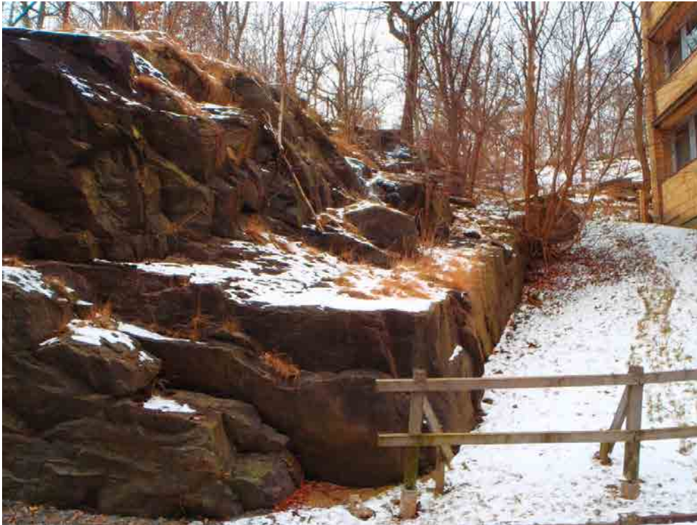
Foto 1. Bergskärningen söder om Språskrapan bedöms idag vara stabil. Tomtgränsen mot eventuell nybyggnation vid Carlandersplatsen löper uppe på släntkrönet högst upp till vänster i bild. Bild tagen mot sydväst.
