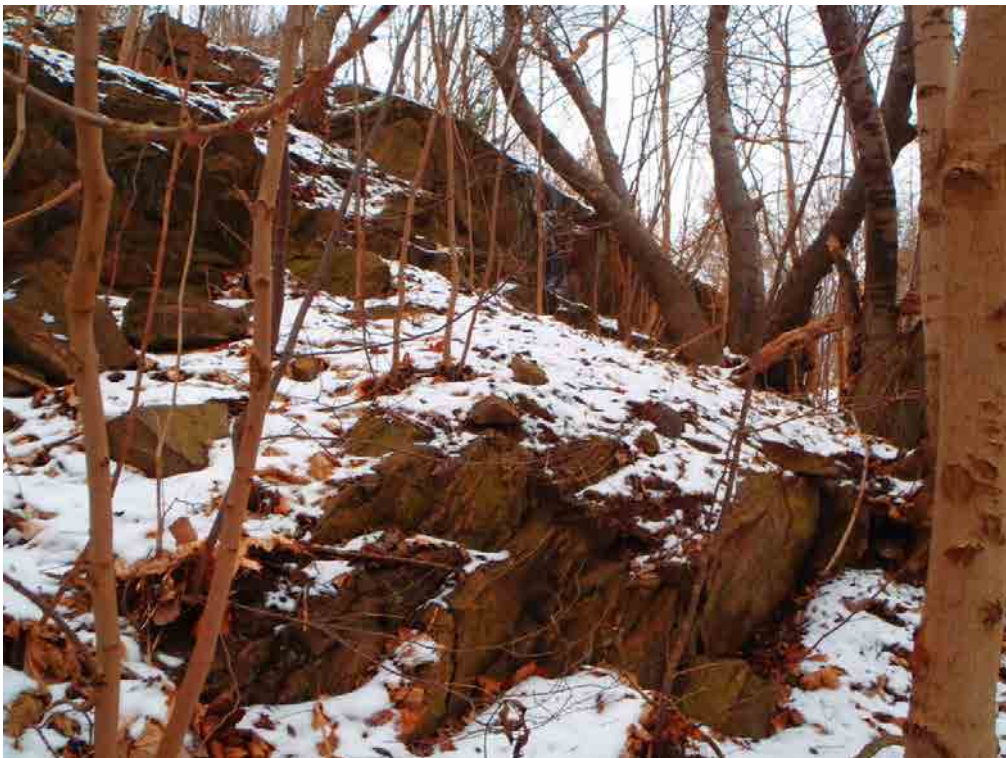
Foto 6. Ca 20 m väster om bergskärningen, uppe i slänten, finns en bergskant. Bergskanten utgörs delvis av en skivighetszon, längst ner i bild. Högre upp i slänten och längs Bernhard Karlrens Gångväg finns fler skivighetszoner. Bilden tagen mot norr.
