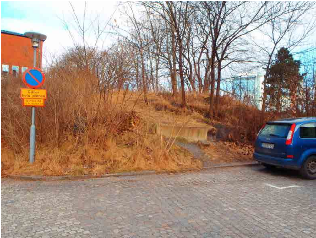
Foto 3. Bergblottning norr om Lundgrensgatans norra ände, utanför aktuellt detaljplaneområde. Berget bedöms idag vara stabilt. Bild tagen mot norr.
