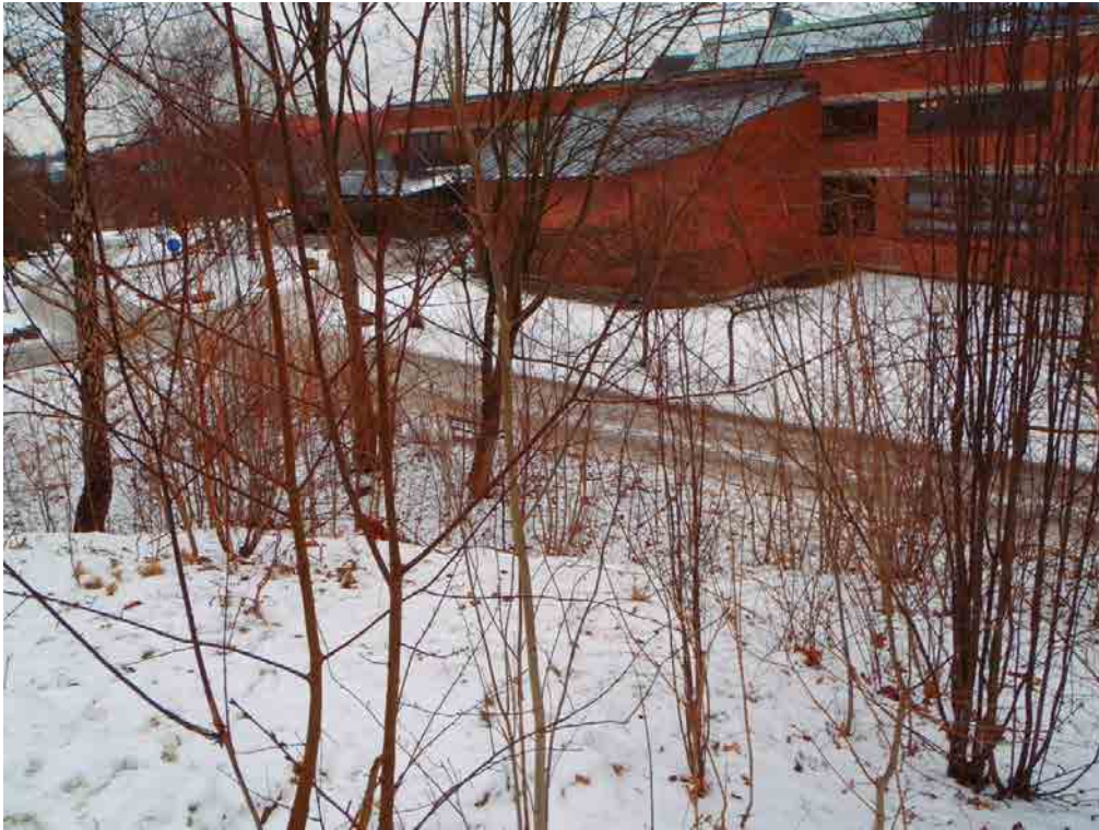
Foto 3. Område för eventuell tillbyggnad. Foto taget mot nordväst.
