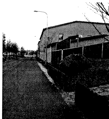
Eklandagatan mot öster, transformatorn i förgrunden
