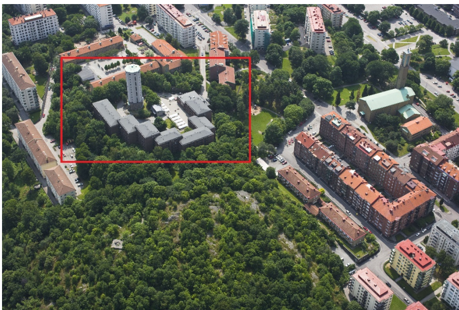
Vybild från norr som visar befintlig byggnad (Rotary studenthem) som föreslås byggas på med en variation av 2-4 våningar. Foto från Stadsbyggnadskontoret.
