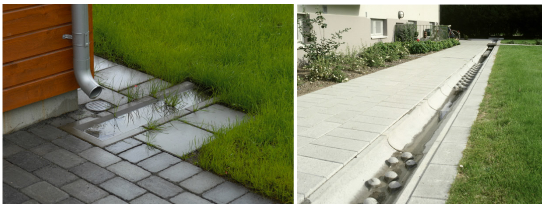
Figur 9: Öppna vattenutkastare och dagvattenrännor. Steriks.se
