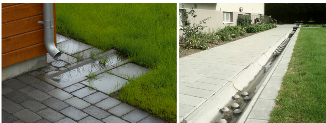
Figur 9: Öppna vattenutkastare och dagvattenrännor. Steriks.se
