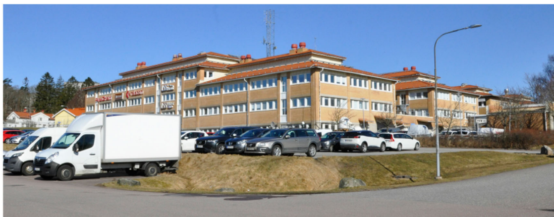
Kontorsbyggnad söder om Radiovägen, uppförd på 1990-talet som en stor sammanhängande volym, Antiquum 180829
