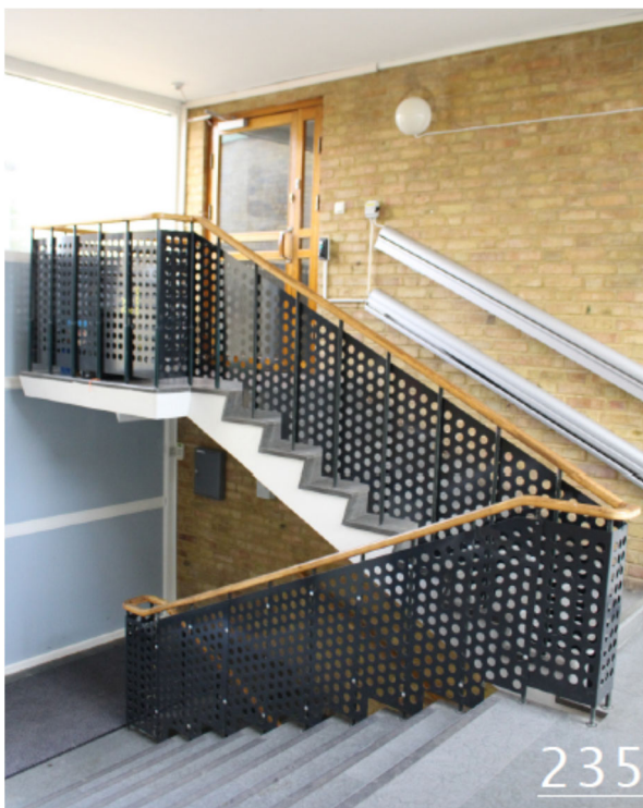
Trapphus och dörr bevarat från byggnadens uppfarandetid utöver fallskyddsskärmar och skenor för rullstollslift, Tyrens 191008.
