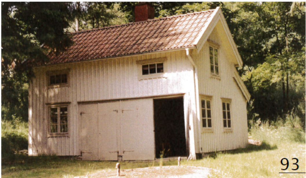
Foto från 50-talet, befintlig byggnad i den norra delen av prästgårdsträdgården, Tyréns 191008
