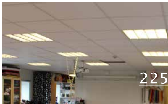
Figur 225. Tak med akustikplattor.
