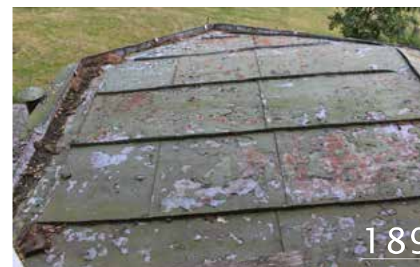
Figur 188. Stora mängder fukt och under lång tid orsakar till slut röta i virke och påväxt. Risk finns att virket redan är utsatt av röta. Det är viktigt att inte bara åtgärda skadan, utan även orsaken, som t.ex. eventuell markfukt.
