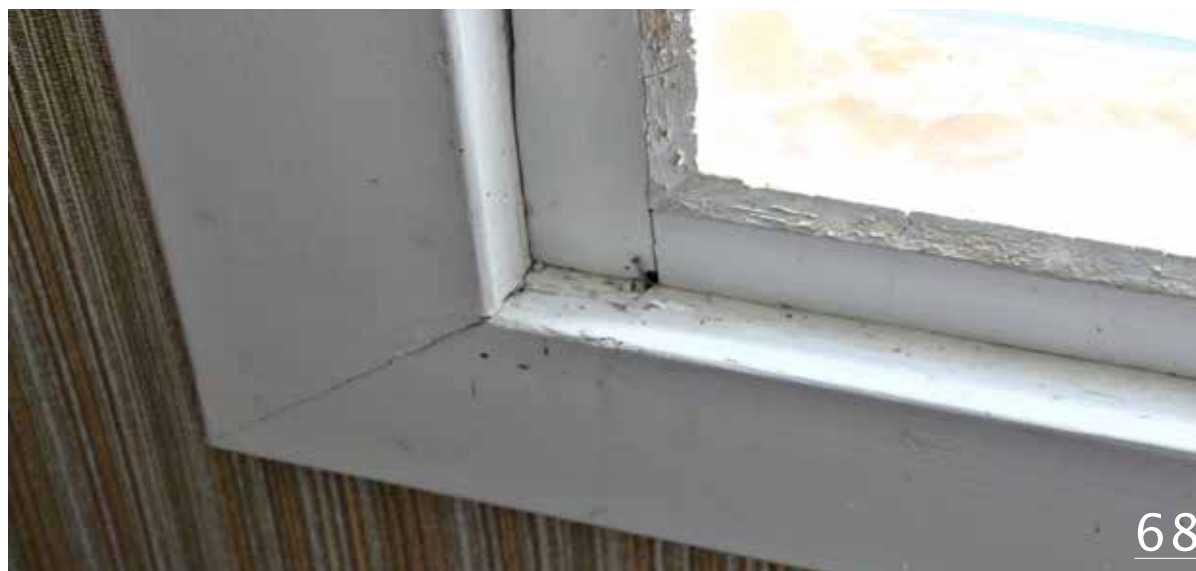
Figur 67. De flesta inre fönsterfoder i den äldre prästgården har samma typ av äldre och detaljerade profilering.
