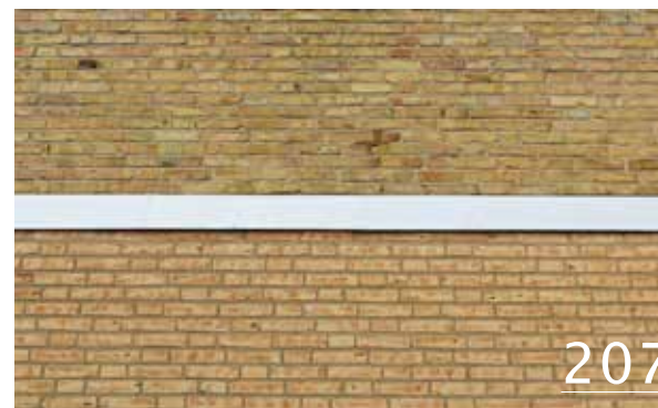
Figur 206. Delarna där nytt tegel har tillkommit avviker synligt från det äldre, här genom att vara mer homogent i kulören med mörkare bruk.
