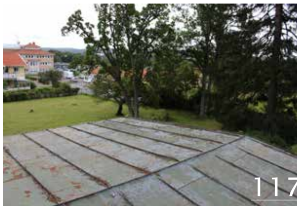
Figur 118. Även på utbyggnaden åt söder är taket lagt med grönmålad skivplåt.
