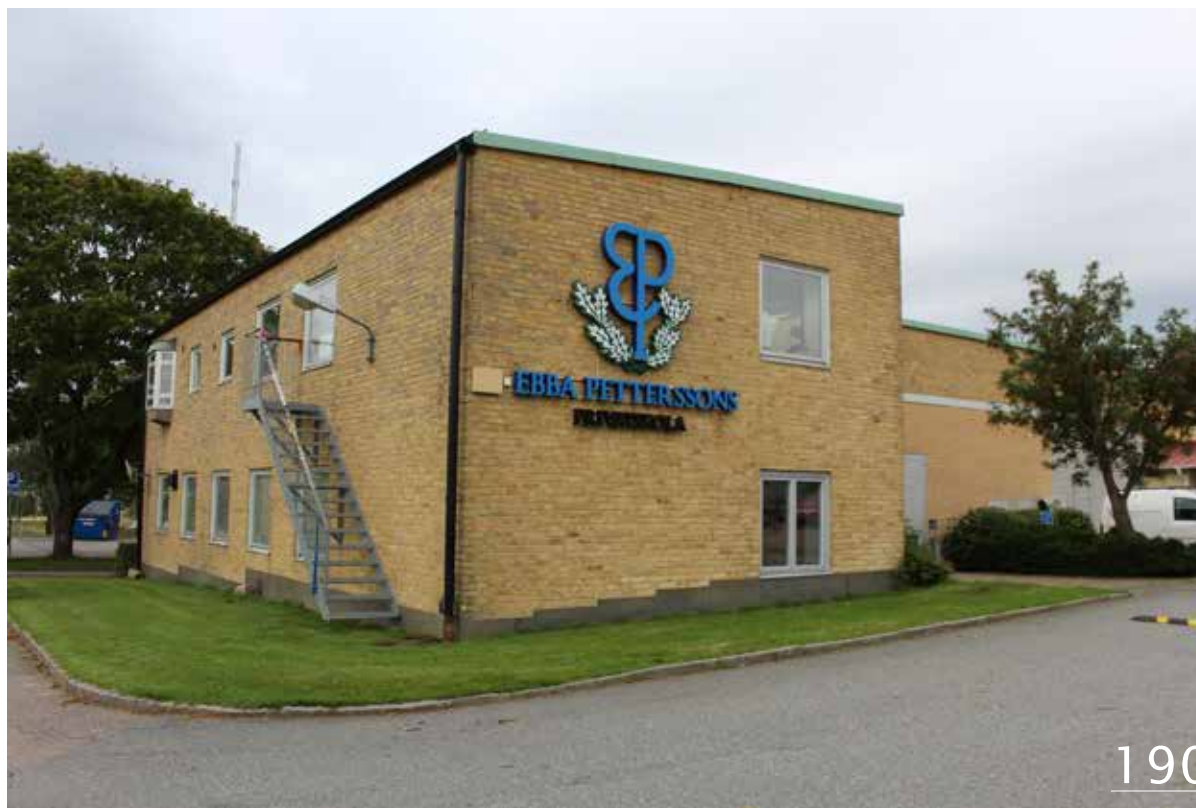
Figur 190. Rundradiostationen består av två separata byggnadskroppar. Den mindre av dessa innehåller bl.a. slöjsalar och personalutrymmen.
