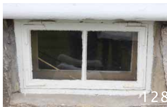
Figur 126. Fönstren på bottenvåningen utgörs primärt av korspostfönster.
