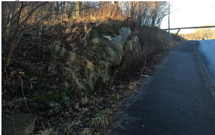
Foto 6. Bergsbranter/skärningar delvis jordtäckta utmed Radiovägens södra del
