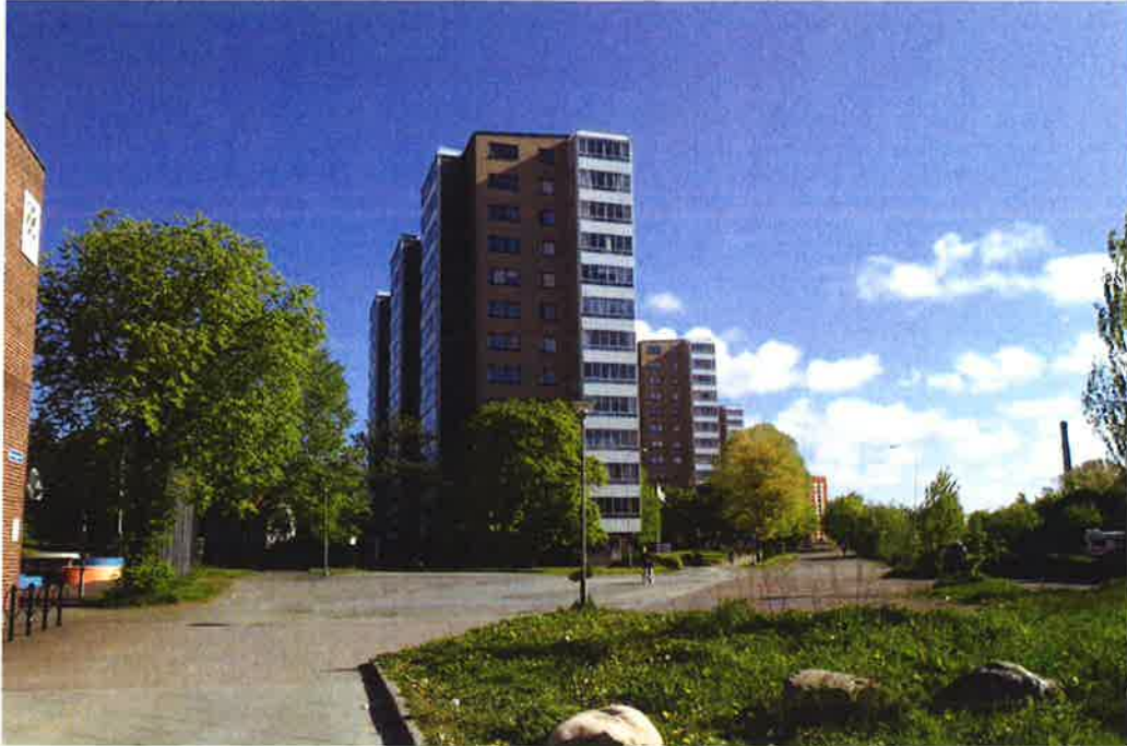
Mandolingatan och befintliga skivhus från Frölunda torg sett.
