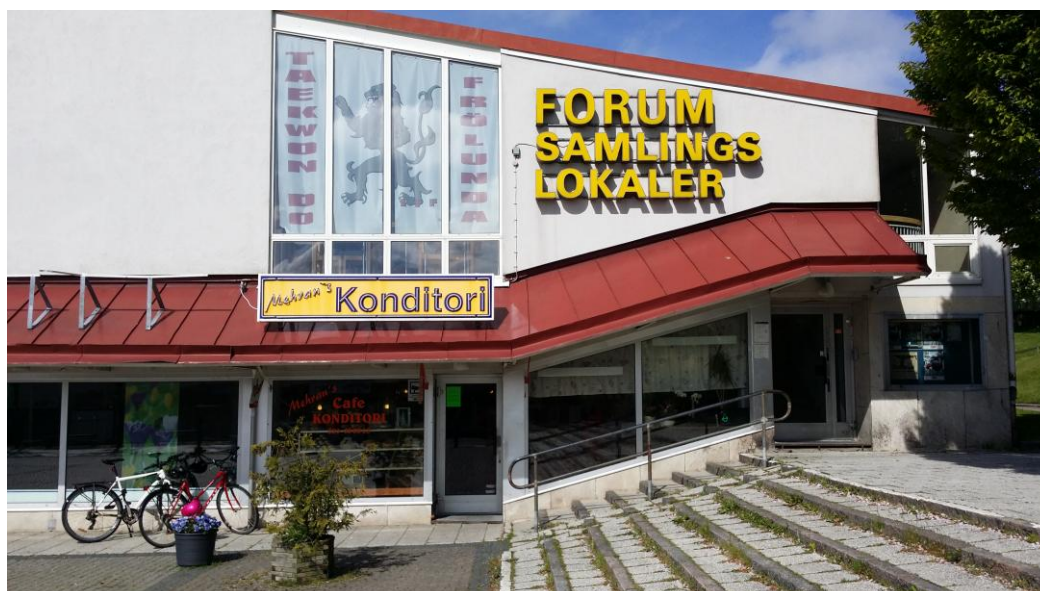
Bild som visar detaljer på Forum-byggnadens västra fasad mot torget och trappan.
