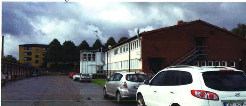
Lokaler inom planområdet. Till vänster i bild fd Motortekniska gymnasiet som tills byggnaderna rivs används för bl a transitboende. Övriga kommunala verksamheter i planområdet kommer att flytta till årsskiftet 2016/2017.
