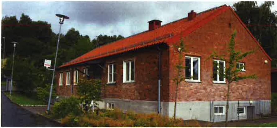
Byggnaden "Axet" inom planområdet, används för daglig verksamhet för funktionshindrade.
