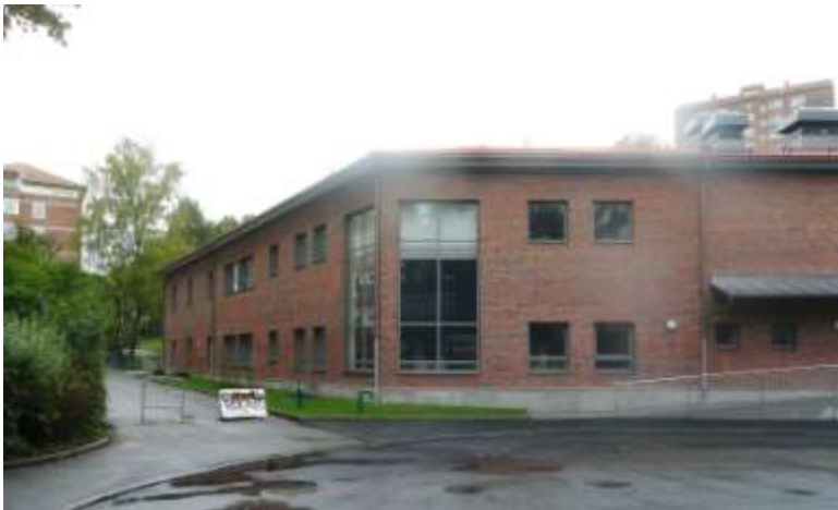
Nybyggd förskola på Södra Victoriagatan.
