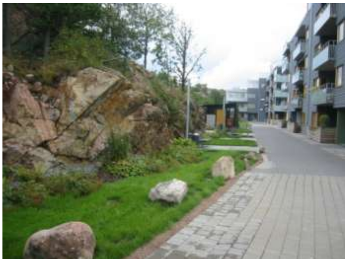
Kvartersgata med en utformning som ger en fin skala. Betongsten i ett par olika format och färger används.
